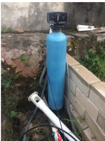
Figura 19. Aldo León, 2018, Rancho el Capricho, Ixtapa, Chiapas Sistema de potabilización de agua.
