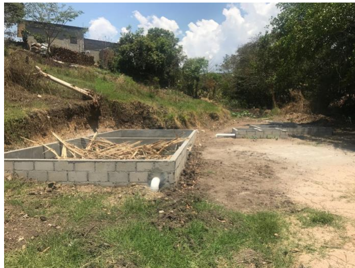
Figura 17. Aldo León, 2018, Comunidad de Cuauhtémoc, Ixtapa, Chiapas. Ultimo estanque de plantas acuáticas sin filtración de agua residual
