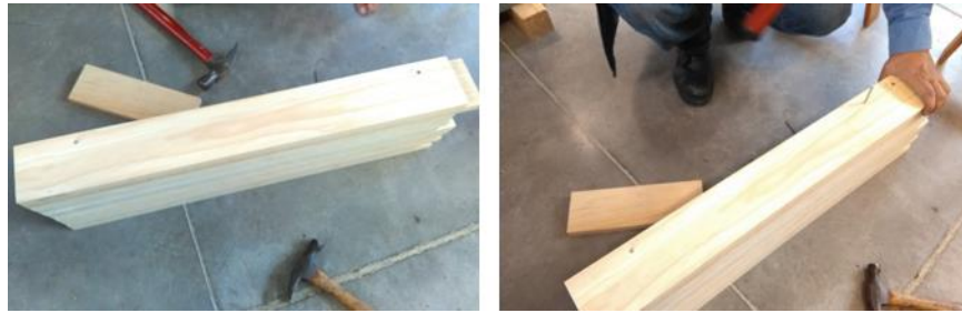
Figura 38. Fabricación de losas de madera laminada clavada (Elaboración propia).
