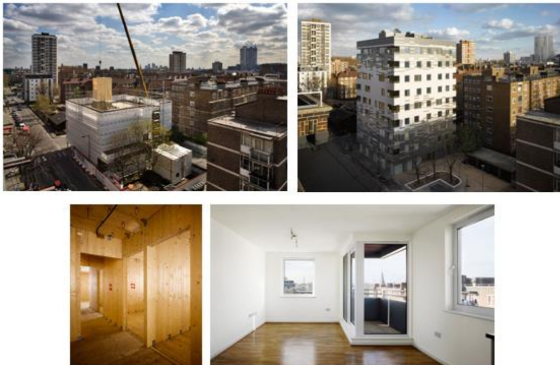
Figura 12. Fotografías del edificio Stadhaus en Londres. (KLH, 2009).
