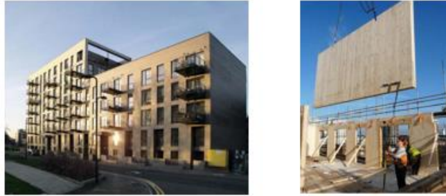
Figura 13. Fotografías del edificio Bridport House. (Ryan, Griffin, & Rice, 2015).
