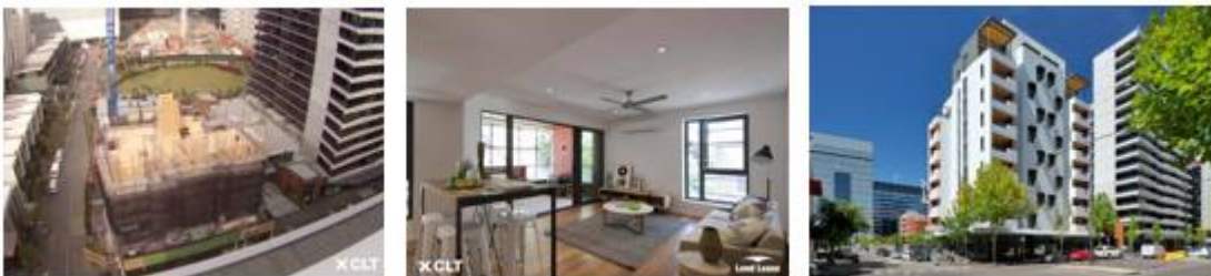
Figura 14. Fotografías del edificio Forté. (Lend Lease, 2013).
