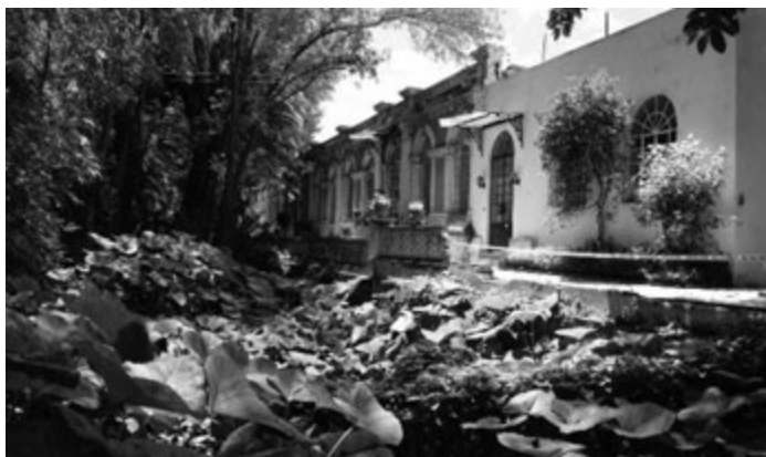
FIGURA 8.1 VIVIENDA AL INTERIOR DE LA FÁBRICA
