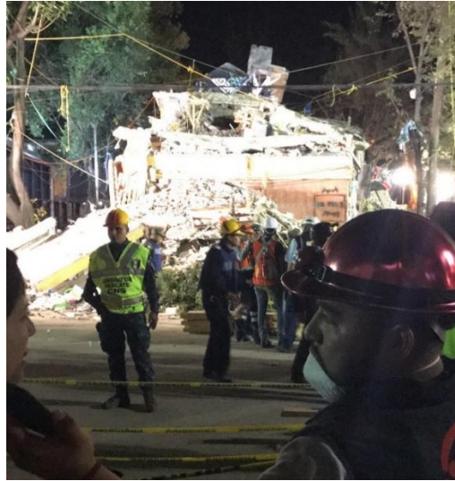
Figura 14. Colapso de multifamiliar en Taxqueña, CDMX Fuente: Fotografía propia. (Uribe, 2017)
