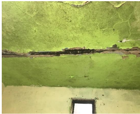
Figura 19. Estado de viguetas en vivienda de Cajititlán
