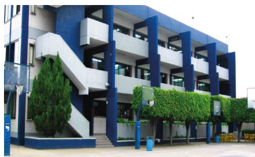
Imagen 10 Instalaciones Colegio Altamira
