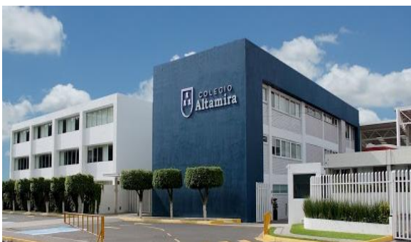
Imagen 9. Entrada Colegio Altamira.
