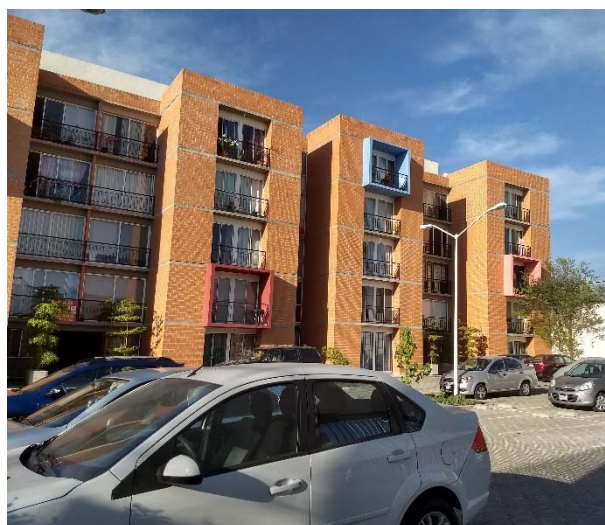
Ilustración 12: Fachadas Torres Altos del Cortijo Fuente: Elaboración propia
