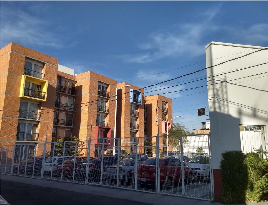
Ilustración 9: Fachada Principal Torres Altos del Cortijo
