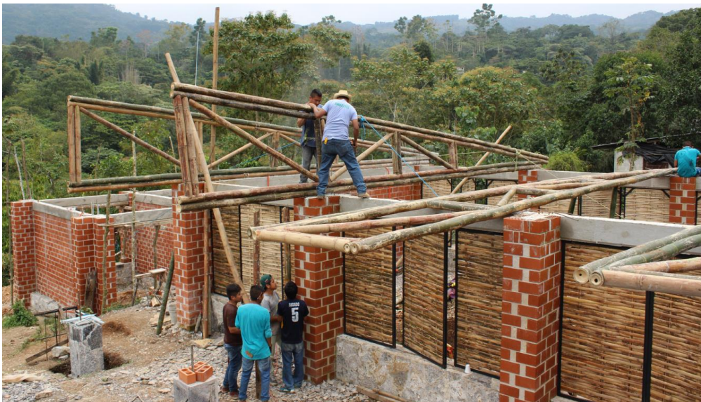
Figura 93. Construcción escuela rural productiva. Fuente: ArchDaily (2019).
