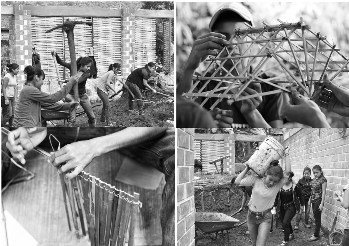
Figura 92. Construcción escuela rural productiva. Fuente: ArchDaily (2019).
