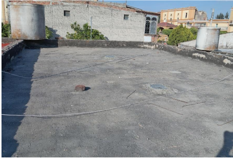
Nivelación de azotea
