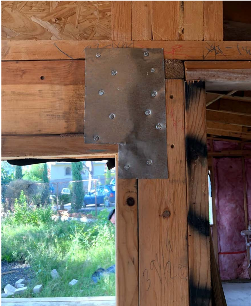
Fig. 3 (Detalle Conexión Metálica)
