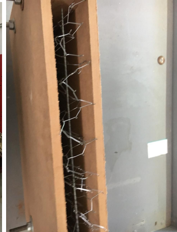
Fig. 5 Armado en cimbra
