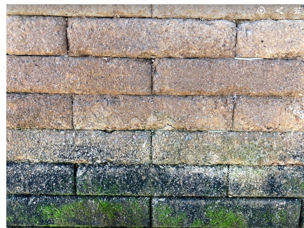
Fig.6 Enlamado del Block
