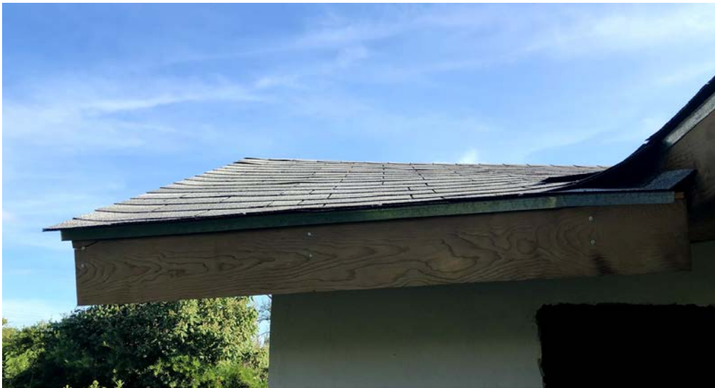
Fig. 7 (Detalle Teja Asfáltica y Gotero)
