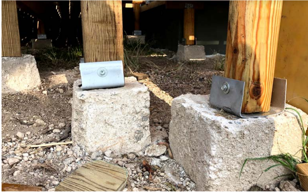
Fig. 4 (Detalle Cimentación)
