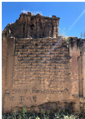
Fig.13 Muro de Adobe con intervenciones visibles
