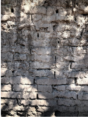
Fig.7 Muro de estacionamiento
