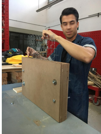
Fig. 4 Colocación de armado
