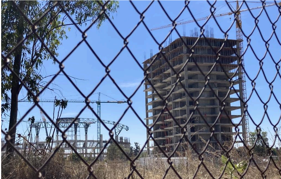
Imagen 24. Vista actual del predio donde se encuentra DI y el Polideportivo. Fuente: Archivo propio
