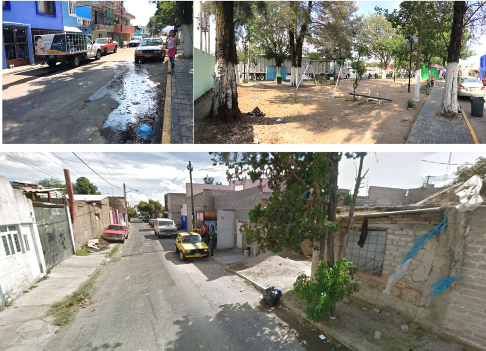
Figura 18 Fallas en sistema de alcantarillado, mínimo espacio verde abierto y deficiencia en algunas calles del barrio Francisco Sarabia
