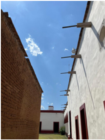
Imagen 5: Diámetros de gárgolas existentes.
