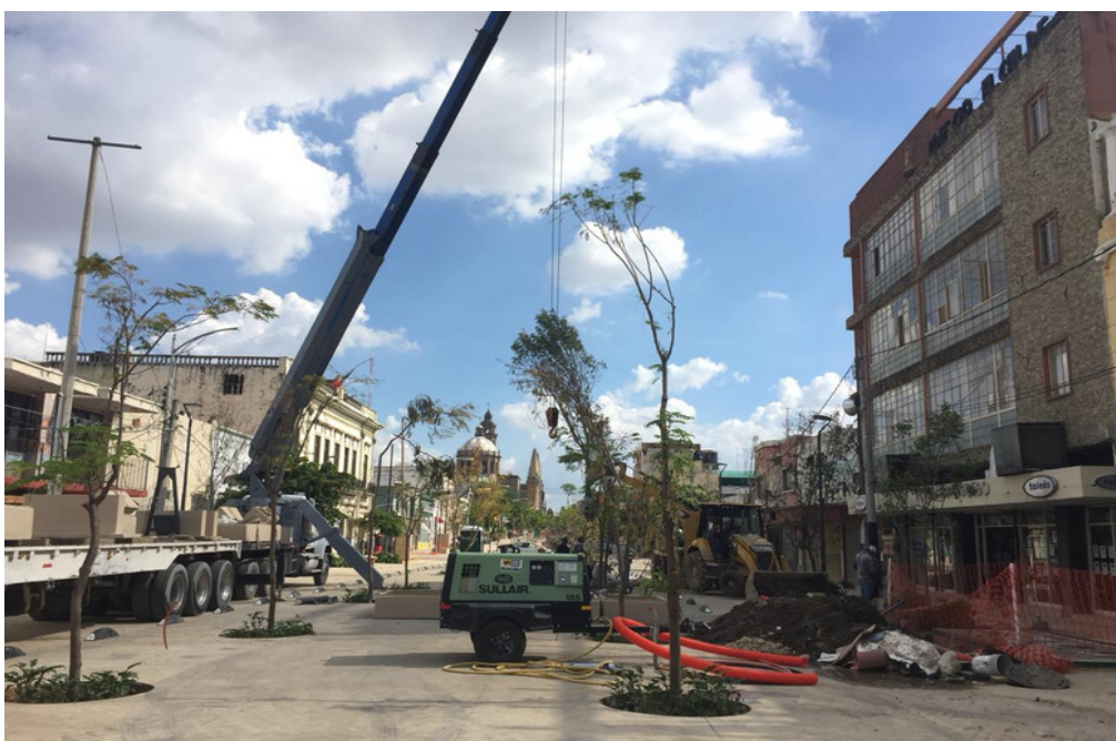
Av. Fray Antonio Alcalde se encuentra en obra, colocación de arbolado.
