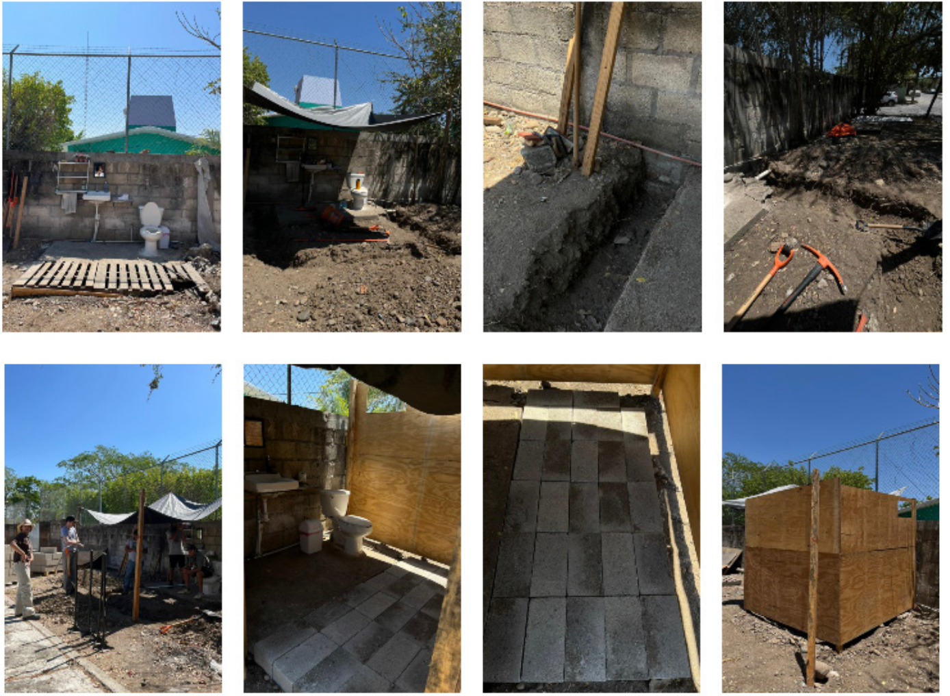
Proceso de desmantelamiento del baño
