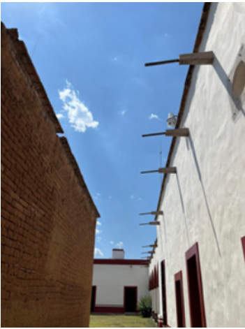
Imagen 5: Diámetros de gárgolas existentes
