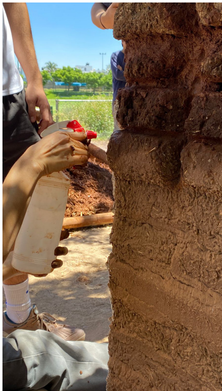
Taller interino de consolidación de grietas en muros de adobe en ITESO
