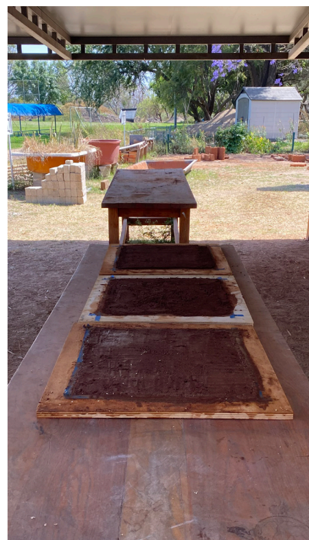
Taller interino de preparación y aplicación de estucos en ITESO
