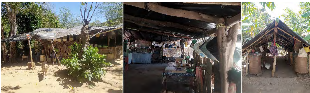
Figura 21. Casas y espacios de guardado construidos con madera y plástico.
