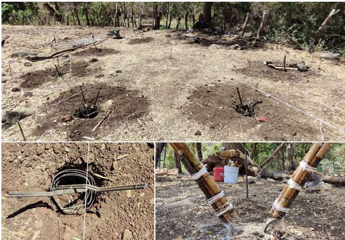
Figura 44. Replanteo y excavación de cimientos.
