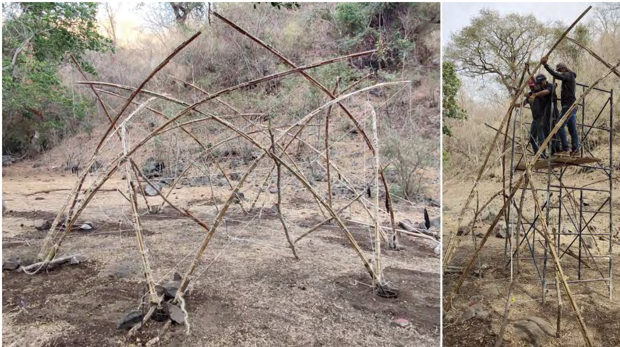
Figura 45. Arcos sujetos en las bases y posterior ajuste de la posición final.
