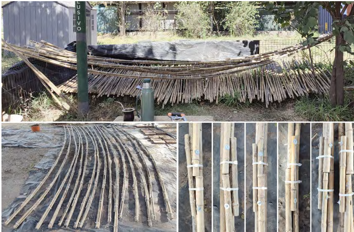
Figura 43. Arcos de sección compuesta, uniones y almacenaje de culmos.
