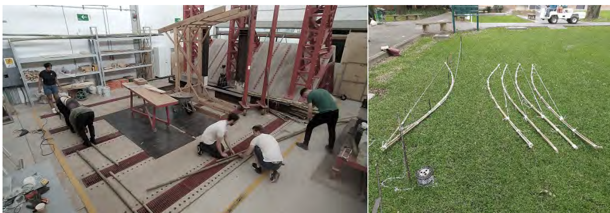
Figura 27. Proceso de ejecución de arcos de sección compuesta
