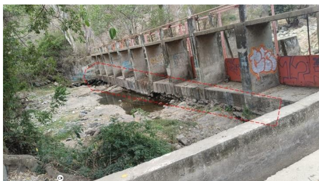
Figura 35. Resultado de la acción de la fuerza ejercida por el flujo de agua que cae sobre el paramento de la cimentación de las compuertas. (Autoría propia).
