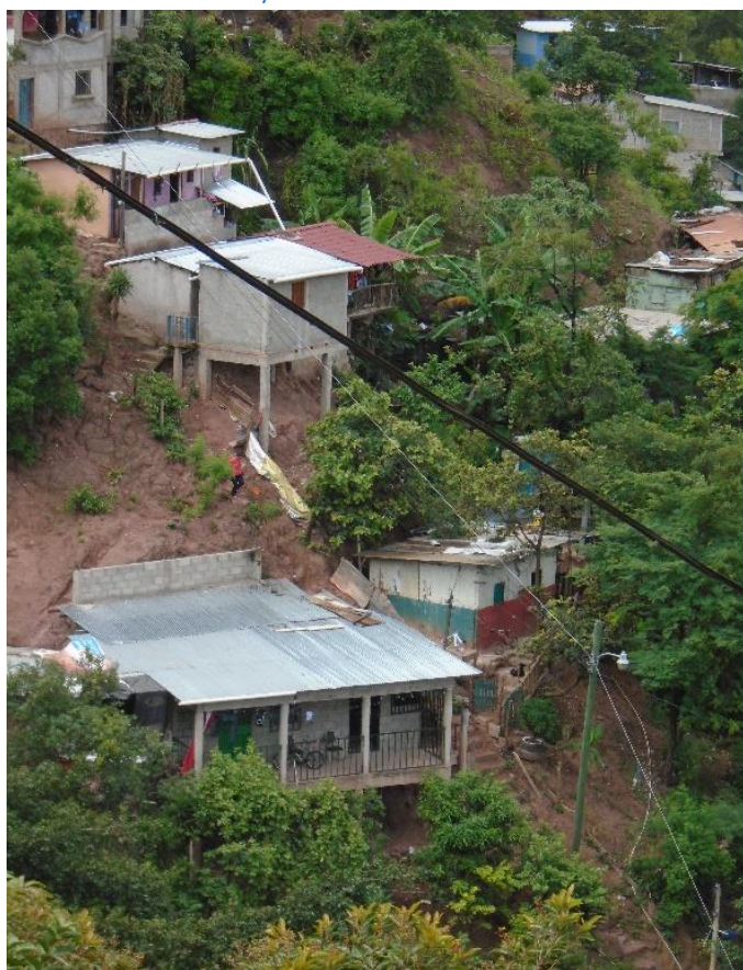
Ilustración 2-5 Viviendas construidas en pendientes pronunciadas con vulnerabilidad a deslizamiento de tierras, Col. Villanueva Tegucigalpa, Fuente: Propia, año 2020
