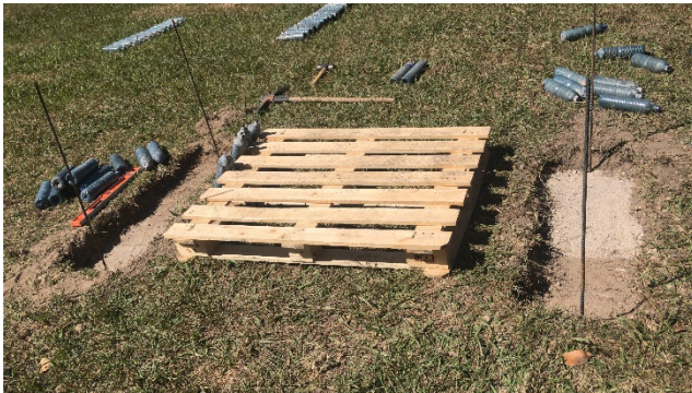
Imagen. 5. Trazo, limpieza y nivelación del área de construcción de bancas hechas con PET.
