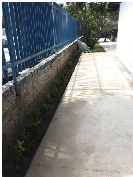
Imagen.4. Se plantaron algunos arbustos tipo “boxos” para generar una mejor imagen en el pasillo que conecta al area de trabajo
