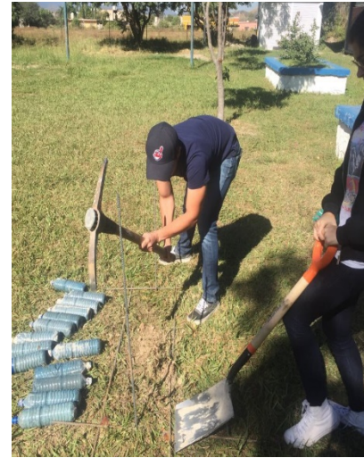
Imagen. 5. Trazo, limpieza y nivelación del área de construcción de bancas hechas con PET.
