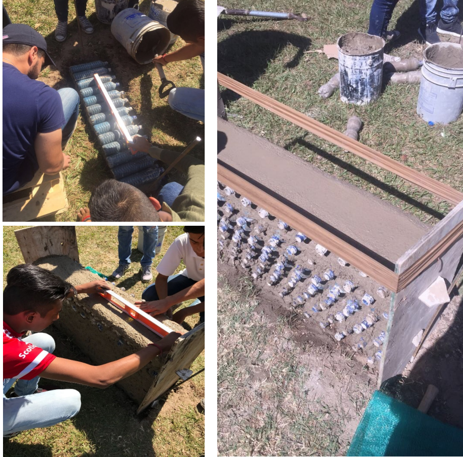
Imagen. 7. Nivelación en cada hilada para cuidar el resultado del producto final.
