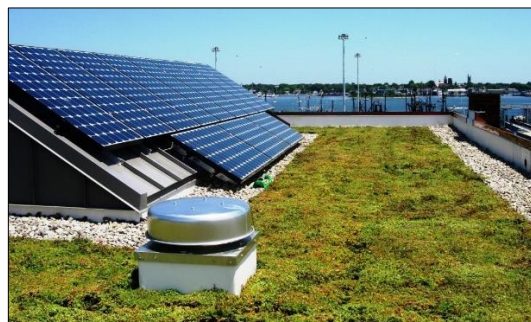
(d) Techo verde y paneles solares
