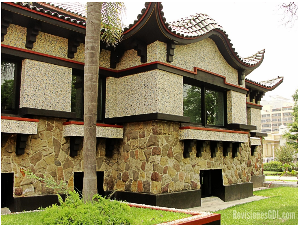
Imagen 5. Detalle de la fachada de la Casa Aviña Bátiz
