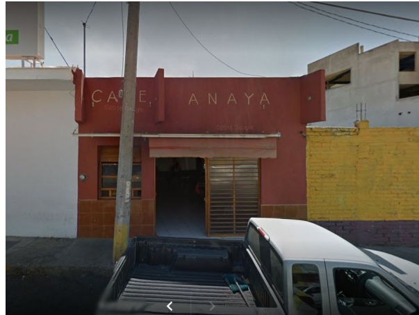
Imagen no. 26: Imagen provisional. Imagen recuperada de Street View, Google Maps; el 25 de abril del 2020.
