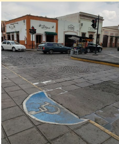
Imagen 50. Rampa en centro histórico Jerez, Zac. Fotografía: Propia (JMC)
