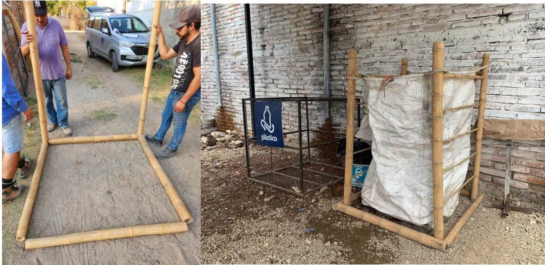
Figura 6. Instalación de contenedor de Bambú.
