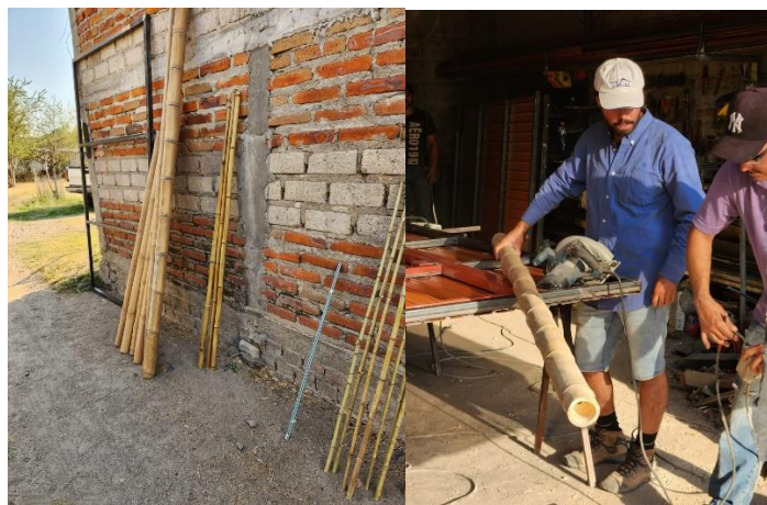
Figura 5. Proceso de corte de contenedor de Bambú.
