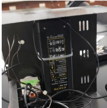
Figura 1.1.7 Sujeción de fuente de poder con cincho a caja del controlador
