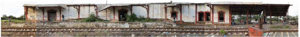
(Condición actual estación Zacoalco de Torres, 2016) (imagen ampliada en anexos)
