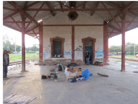
(Condición actual estación Zacoalco de Torres, 2016)
