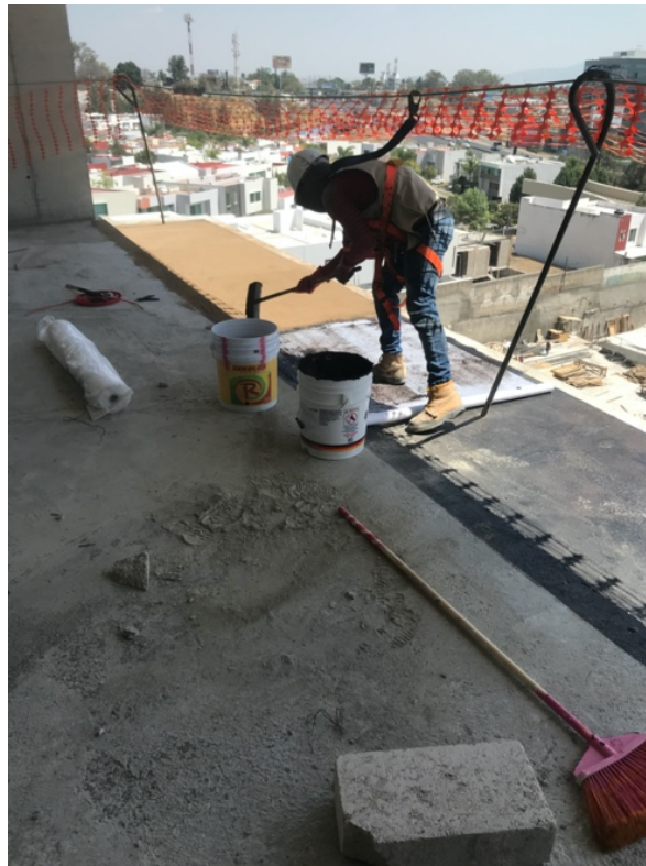
Figura 4.13. Impermeabilización de losas en balcones.
