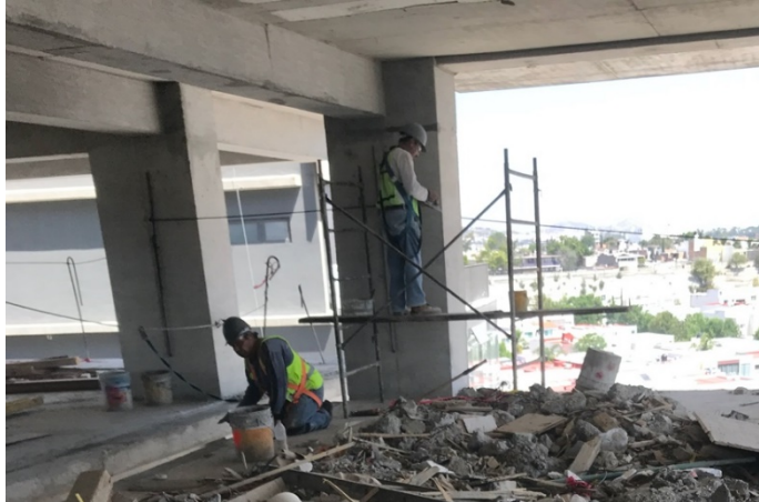
Figura 4.27. Adecuación y detallado de elementos estructurales que no cumplían con la calidad de acabado aparente.
