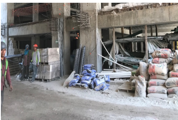
Figura 4.28. Área de almacenamiento irregular de materiales: a) área de almacén y b) Sacos de yeso en un pasillo de la Torre 2.
