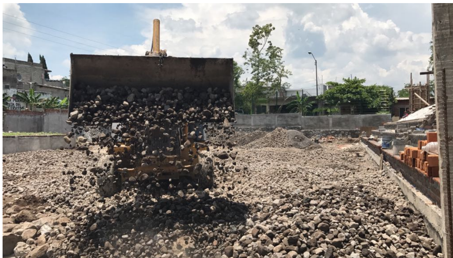
Figura 2.2. Uso excesivo de recursos pétreos para el relleno de una cancha de usos múltiples.
