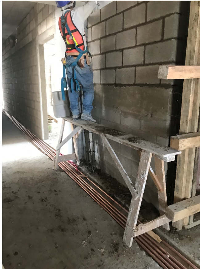
Figura 4.24. Trabajos sobre la instalación de tubería de gas.
