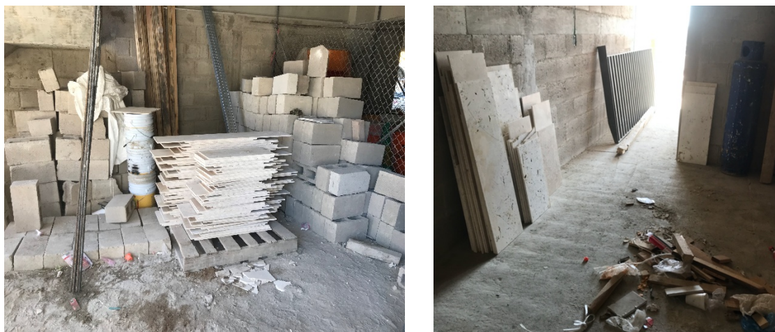
Figura 4.25. Área de almacenamiento de materiales de mármol: (a) piezas de mármol apiladas en zona de almacén; (b) Piezas de mármol en pasillo de Torre 2.
