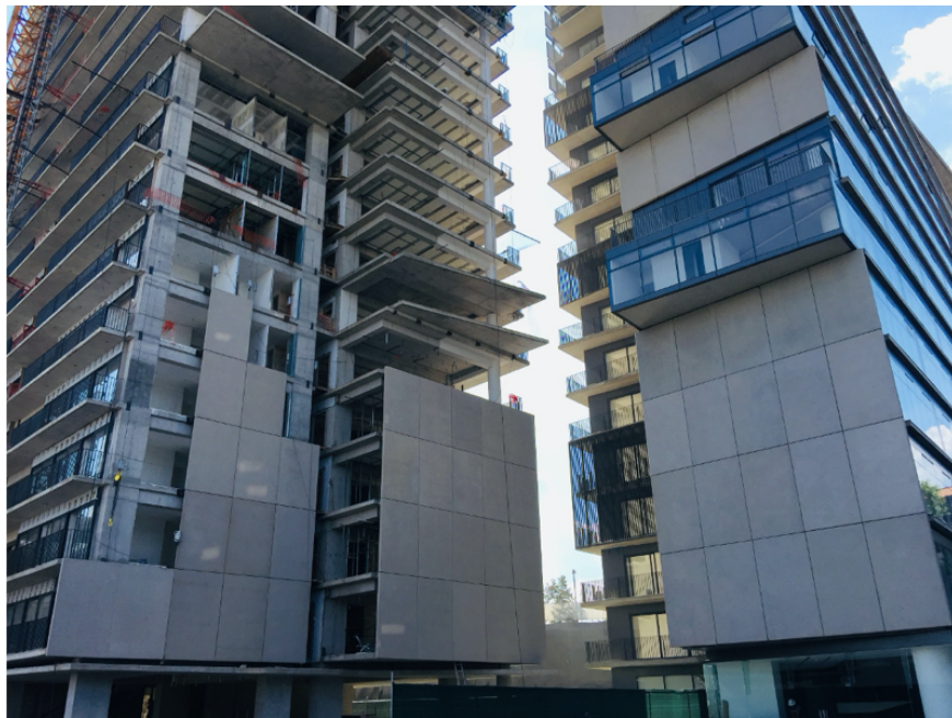
Figura 4.11. Fachada prefabricada de paneles de concreto.
