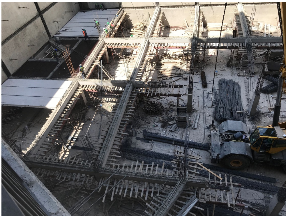
Figura 4.15. Área de construcción de la zona de estacionamiento.
