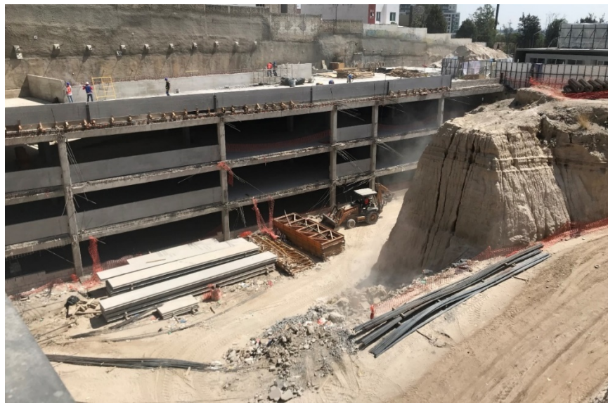
Figura 4.29. Área general de almacenamiento de materiales.
