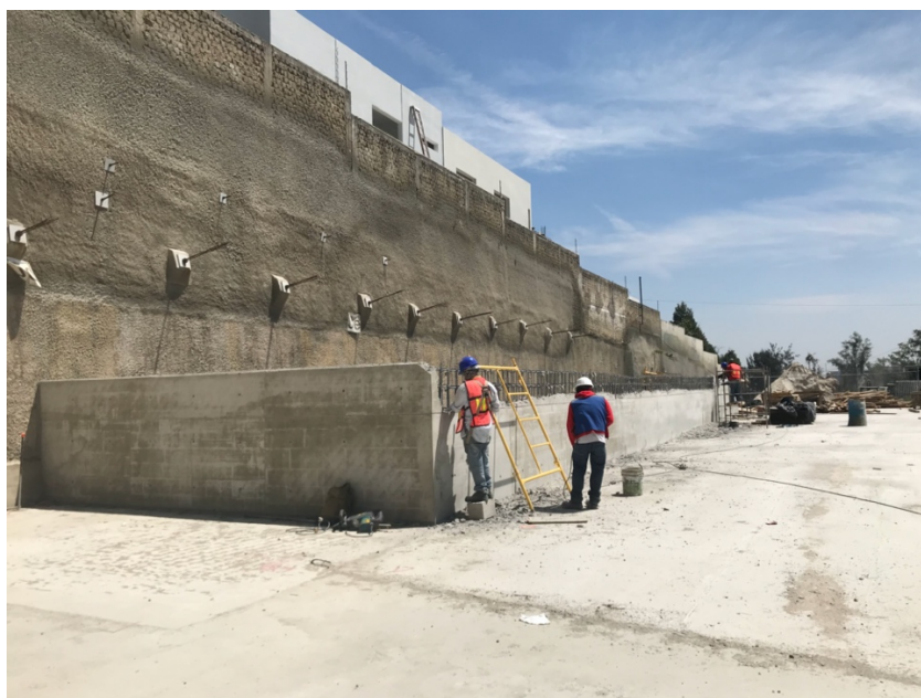
Figura 4.12. Demolición de muro de concreto.
