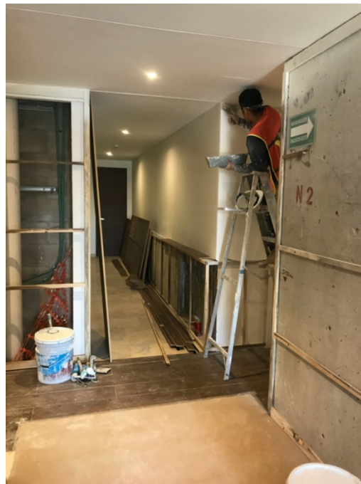
Figura 4.10. Muros con bastidor de madera para lambrin.
