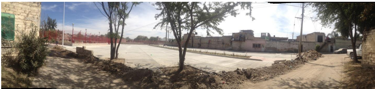
Ilustración 23. Concreto hidráulico sobre vialidad proyectada. (Autoría propia, capturada el día 20 de febrero de 2016.)
