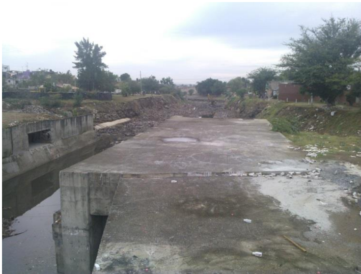
Ilustración 19. Cajas colectoras de drenaje y confinamiento del cauce antes de las obras. (Autoría propia, capturada el día 14 de julio de 2015.)
