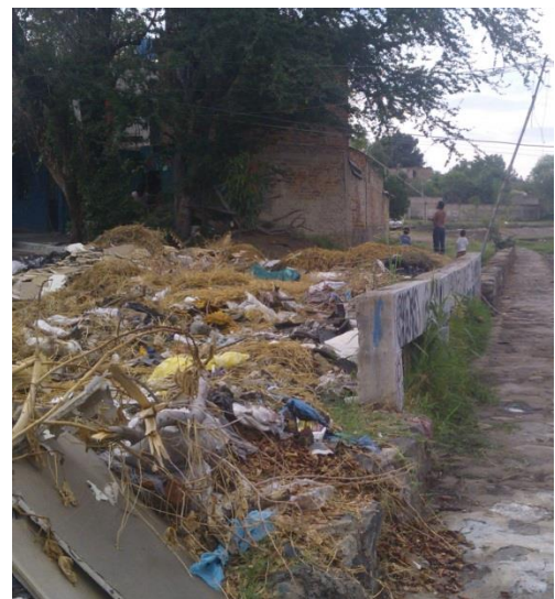
Ilustración 92. Basura y escombros en el margen del cauce, tras la limpieza realizada con maquinaria pesada. (Autoría propia, capturada el día 14 de julio de 2015.)
