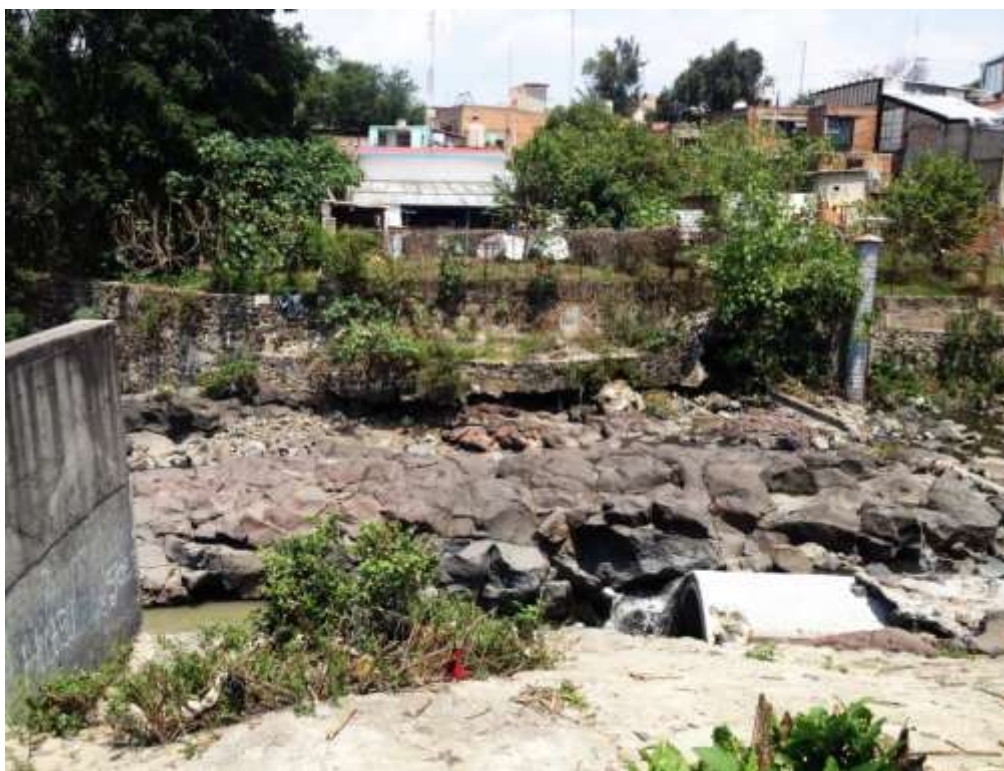
Ilustración 10. Termino del colector sobre el cauce del río San Juan de Dios. Captura propia el 14.06.2015
