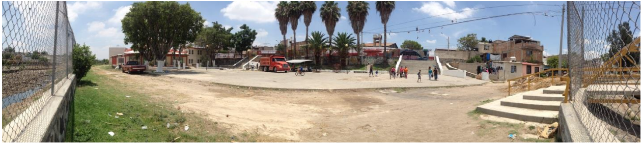
Ilustración 58. Vista panorámica de la plazoleta frente al cauce, a la izquierda la Parroquia Santo Niño de Atocha, al centro en un nivel de piso superior se observa el mercado y a la izquierda, parte del puente peatonal. (Fotografía propia, tomada el día sábado 13 de junio de 2015.)
