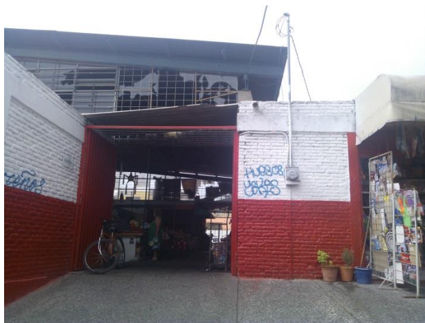
Ilustración 63. Ingreso a la nave principal del mercado. (Fotografía propia tomada el día 13 de junio de 2015.)
