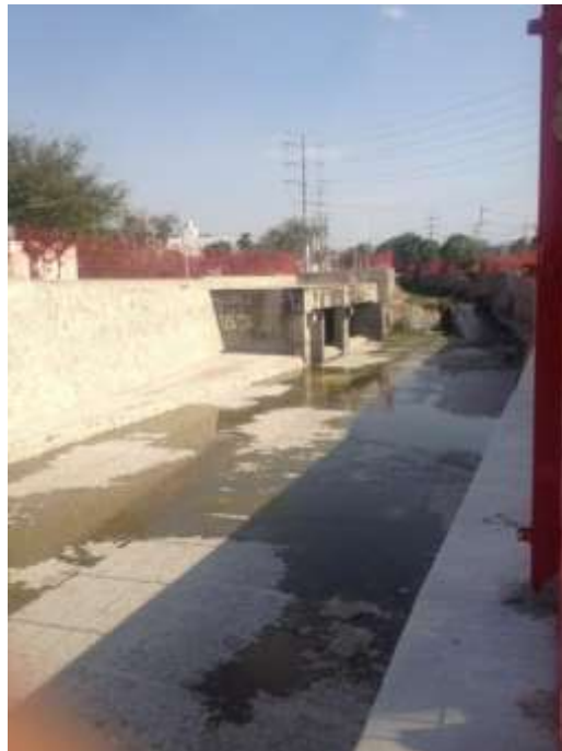
Ilustración 25. Vista a caja de colectores del río San Juan de Dios. Fuente: Propia, 2016.
