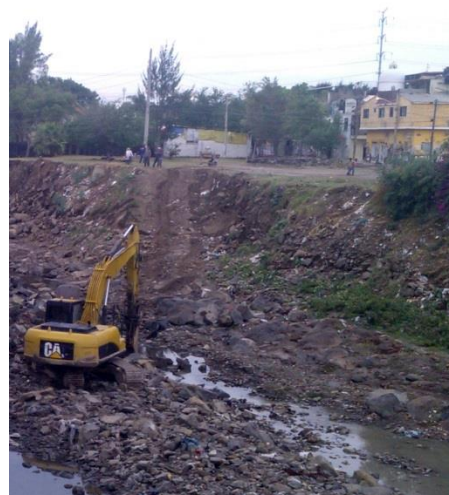
Ilustración 27. Cauce durante las obras, anterior cancha de futbol. (Autoría propia, capturada el día 14 de julio de 2015.)
