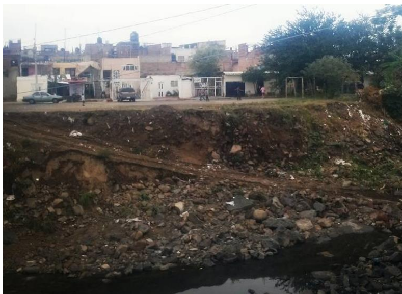
Ilustración 26. Cancha de futbol antes de las obras. (Autor: Yeriel Salcedo, capturada el día 30 de mayo de 2015.)
