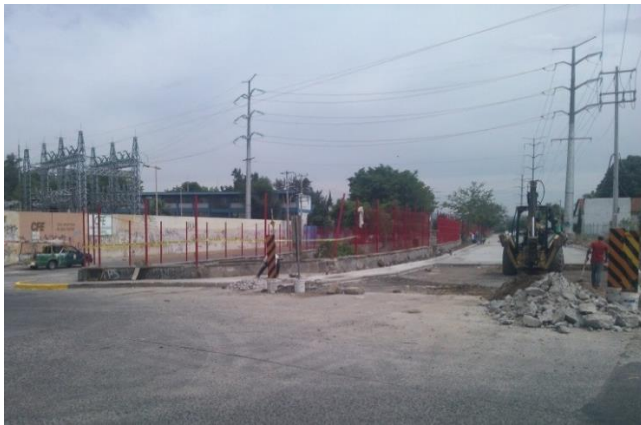
Ilustración 21. Obras sobre Av. Normalistas y Monte Lisboa. (Elaboración propia, tomada el día 14 de julio de 2015.)
