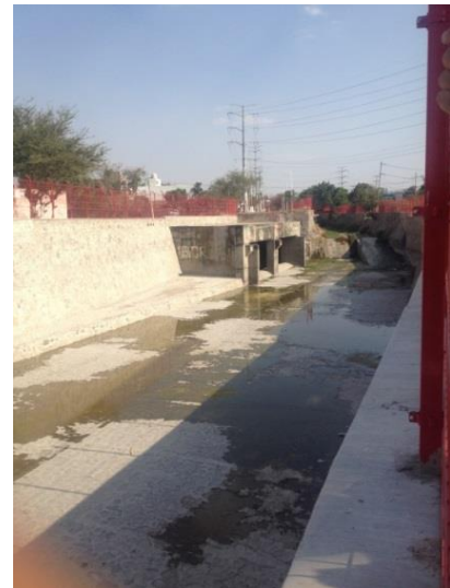
Ilustración 20. Cajas colectoras de drenaje y confinamiento del cauce después de las obras. (Autoría propia, capturada el día 8 de abril de 2016.)
