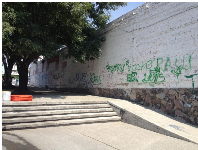
Ilustración 67. Vista del paso peatonal entre el mercado y el CDC 24, previo a la realización de los talleres Arte sin paredes. (Fotografía propia, tomada el día 9 de abril de 2016).
