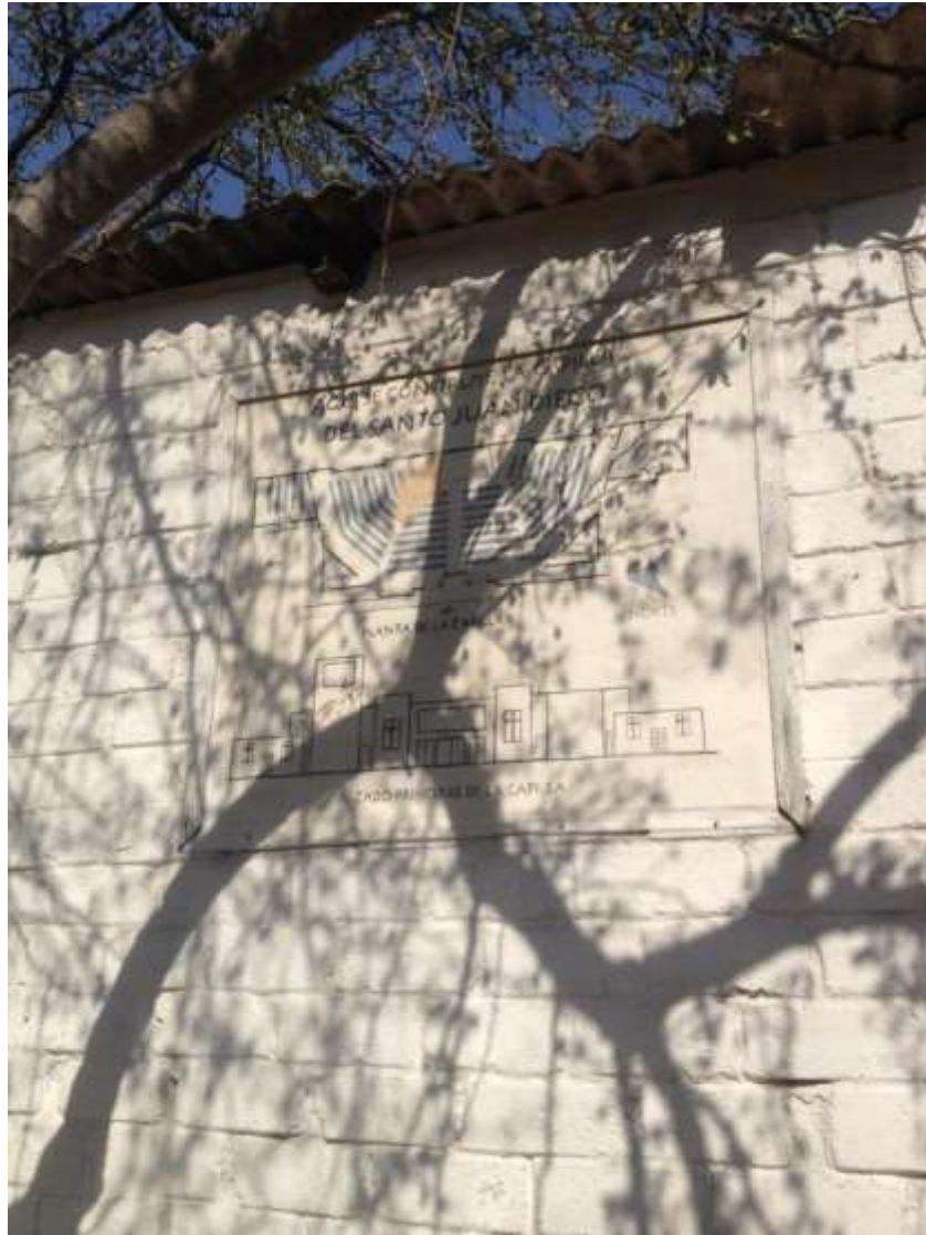
Ilustración 27. Cartel del proyecto de construcción de la capilla del Santo Juan Diego. Fuente: Propia, 2016.
