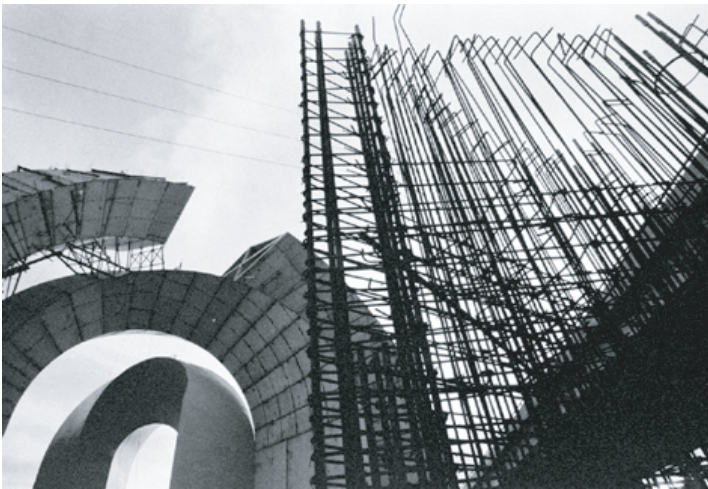
I-17 Arcos del milenio en construcción, 2001.
