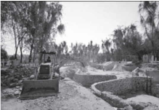
+ Obra en construccin.
