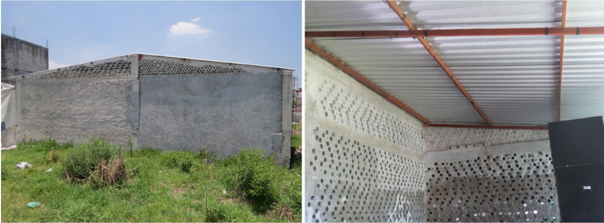
Figura A3. 3. Cubierta de la vivienda.
