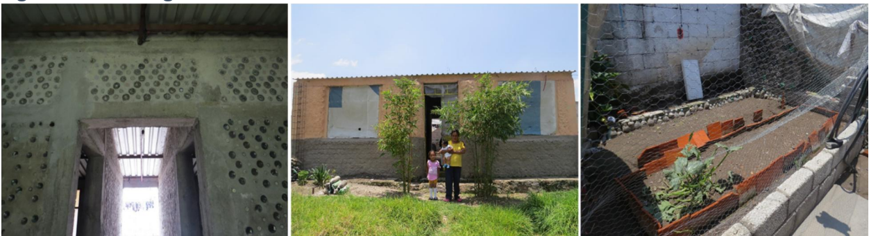
Figura A3. 4. Fotografías de la vivienda construida con botellas PET.
