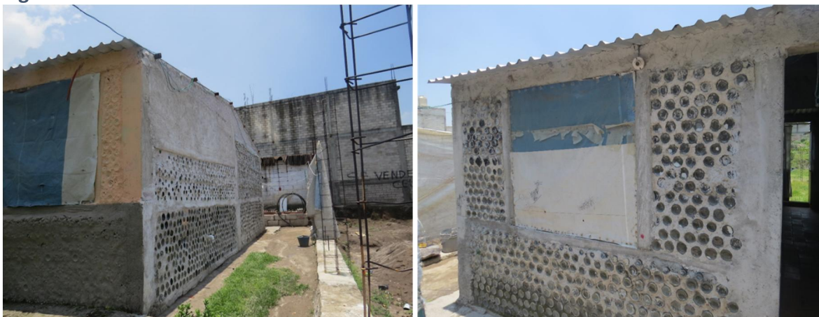
Figura A3. 7. Exterior de la vivienda.
