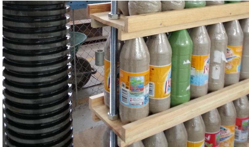
Figura 19. Detalle de las costillas de los tableros de madera.
