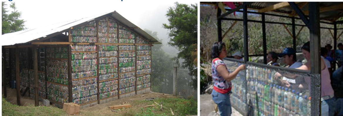
Figura 3. Sistema constructivo pura vida.
