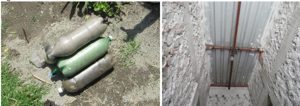
Figura A3. 2. Acomodo de los ladrillos con botellas PET.
