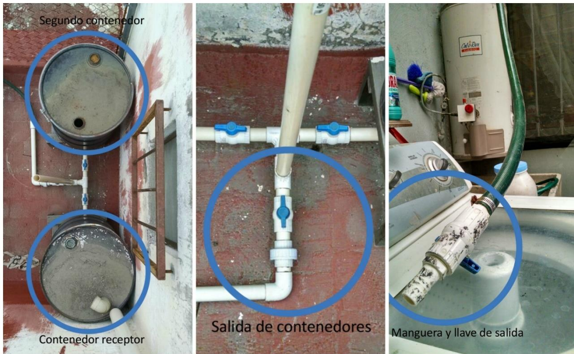
Ilustración 98. Serie de fotografías de contenedores del sistema y salidas. Fuente: Elaboración propia.
