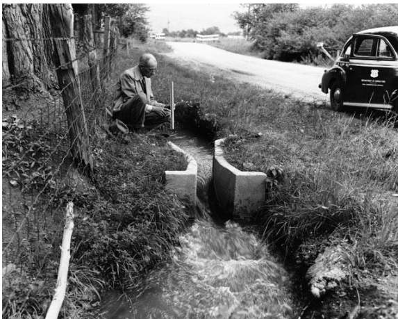
Ilustración 80. Primeras secciones Parshall, Villegas 2012.
