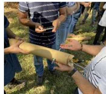
Ilustración 133. Conexión con boca de pescado. Autoría propia
