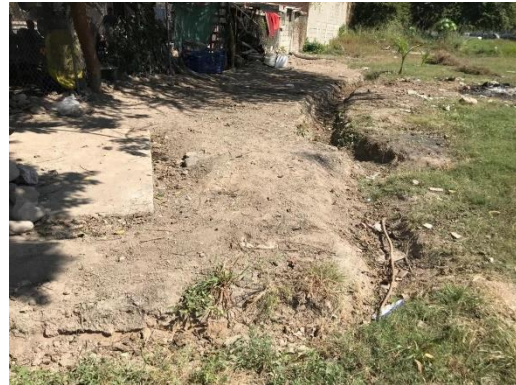
Ilustración 119. Zanjas naturales que evitan el desbordamiento del agua. Fotografía Carlos Estrada. Análisis autoría
