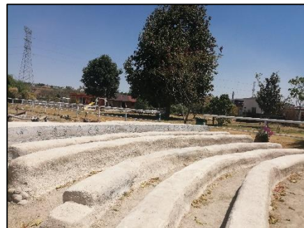
Figura 87. Gradas de superadobe CWG Fuente: Acervo del autor
