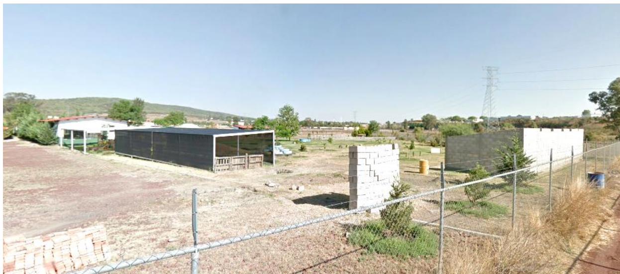
Figura 26. Infraestructura del CWG antes de ser intervenido. Fuente: Googlemaps, 2014
