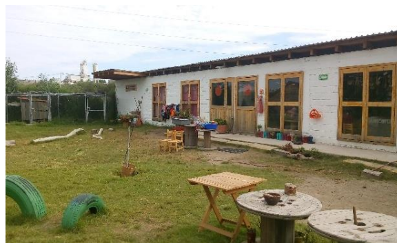
Figura 31. Edificio 1: preescolar. Fuente: Acervo del autor
