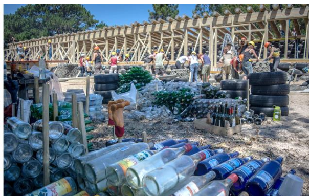
Figura 14. Construcción de escuela No. 294. Fuente: Escuelasustentable, 2018
