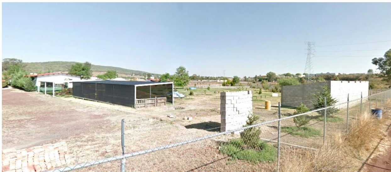
Figura 4. Infraestructura del CWG antes de ser intervenido. Fuente: Googlemaps, 2014
