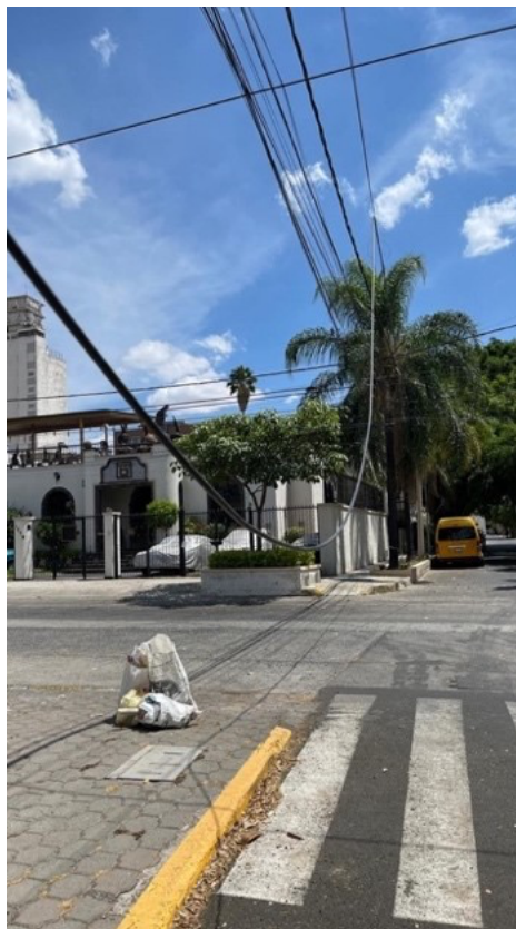
Imagen 4: Cableado en la Americana
