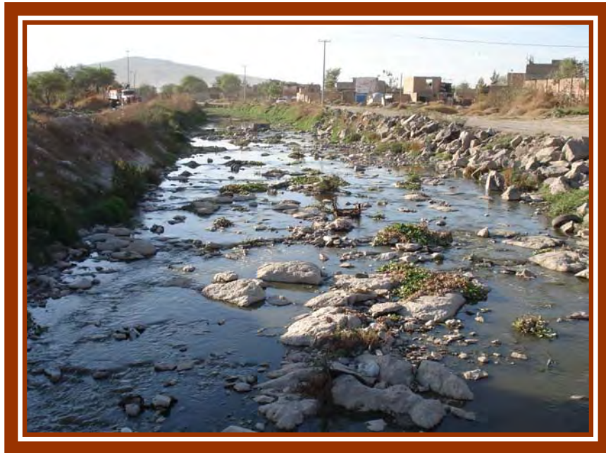
Canal que separa a los sectores de “la Huizachera” y “Santa Rosa del Valle”
