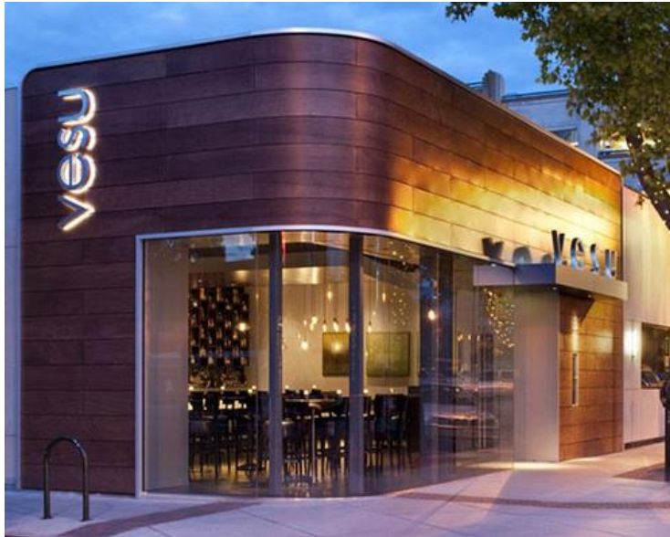
Figura No. 5 Remodelación de una fachada comercial 30
