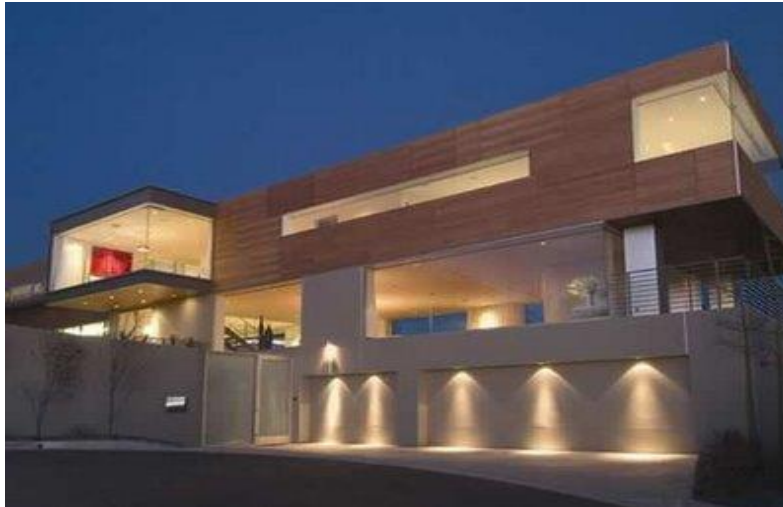
Figura No. 6 Diseño y remodelación de la fachada de una casa 31
