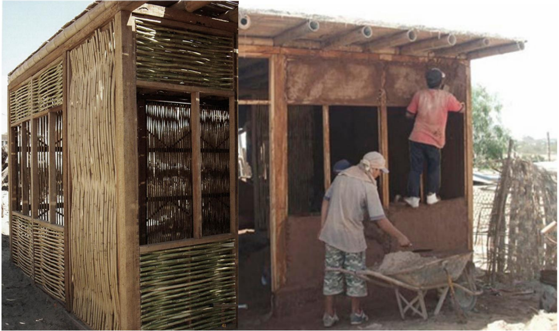
Figura 37 Proceso de "Enquinchado" y "Embarre"
