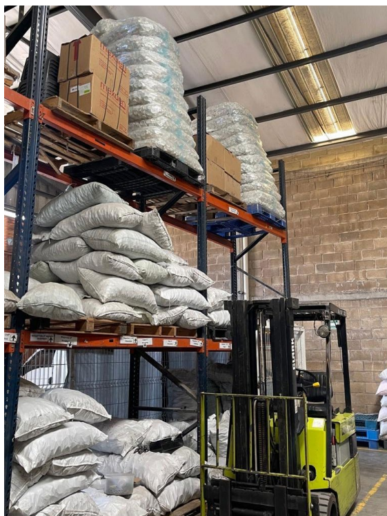
Imagen 64. Evidencia de riesgo “común” en los racks del almacén. Tomada por equipo PAP CC P.2026
