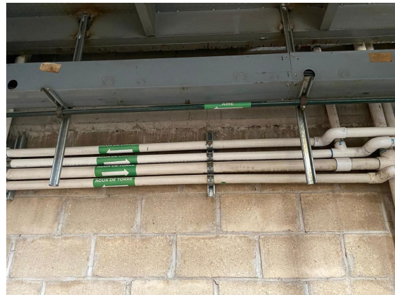
Imagen 20. Evidencia del antes y después de colocar las etiquetas para la identificación de fluidos en tuberías. Tomada por el consultor Jr. Francisco Alejandro Sánchez Gutiérrez.
