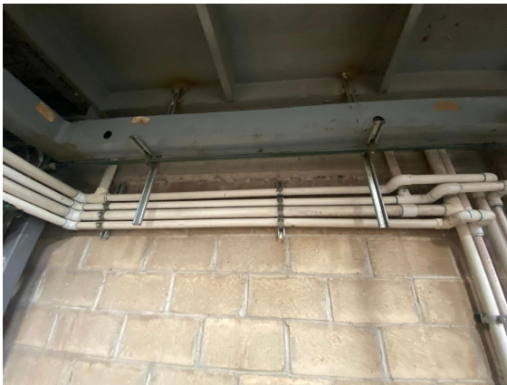
Imagen 20. Evidencia del antes y después de colocar las etiquetas para la identificación de fluidos en tuberías. Tomada por el consultor Jr. Francisco Alejandro Sánchez Gutiérrez.
