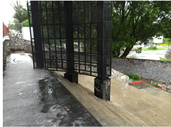
Foto10. Av. Ávila Camacho, acera este vista ingreso.
