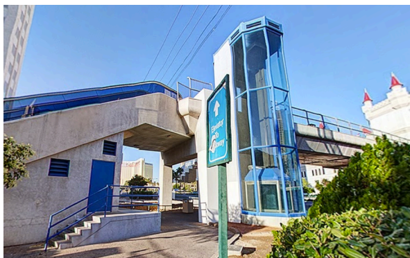
Foto 90. Puente peatonal hotel Flamingo, las Vegas.
