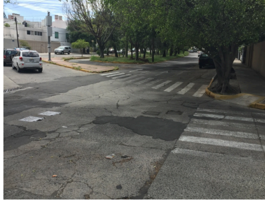
Foto 56. Av. Montevideo, vista este.
