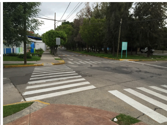
Foto 20. Montevideo, acera oeste vista este.
