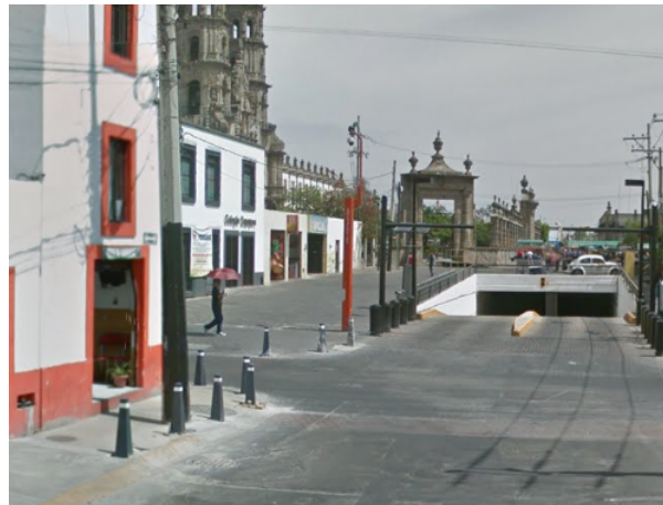
Foto 32. Calle Eva Briseño, acera sur vista norte a Basílica de Zapopan.
