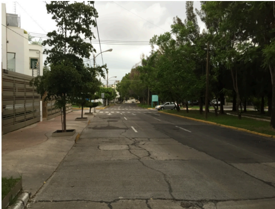
Foto 17. Montevideo, acera oeste vista este.
