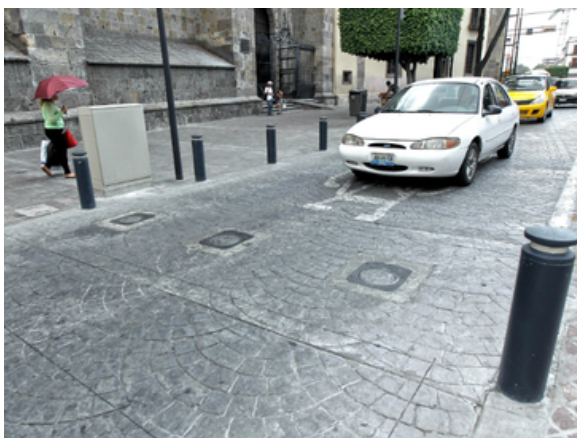
Foto 98. Control de acceso vehicular, Guadalajara.
