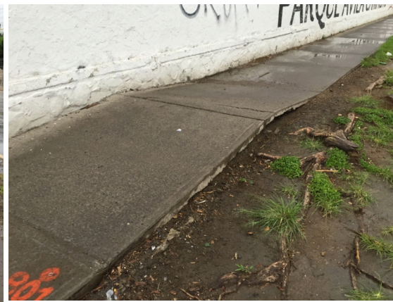
Foto 12. Av. Ávila Camacho, acera este vista este.
