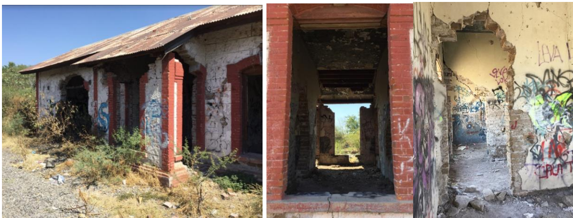
(Estación de Catarina en 2017)
