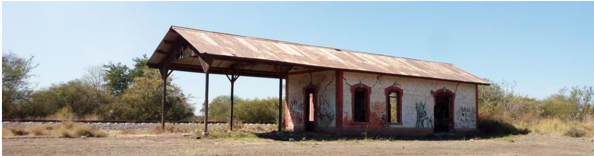
(Estación de Catarina en 2017)
