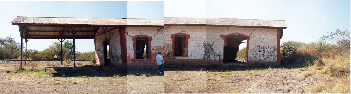
(Estación de Catarina en 2017)
