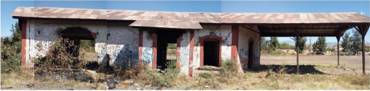
(Estación de Catarina en 2017)
