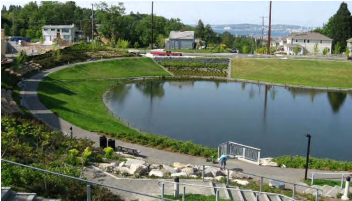
Ilustración 1 Laguna de infiltración
