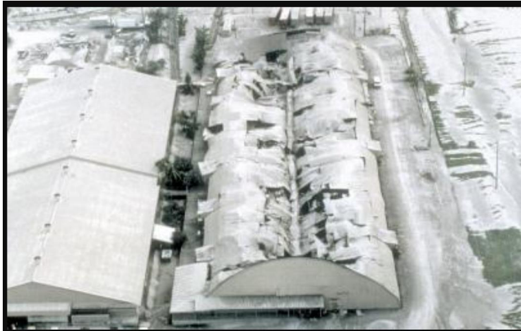
Figura 2.7 El colapso de cubiertas ligeras por el peso de la ceniza durante la erupción del volcán Pinatubo, Filipinas, 1991 provocando la muerte de 300 personas (USGS, 2010).
