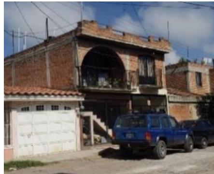
Figura 5.6 Vivienda tipo C-2 con muros de adobe.
