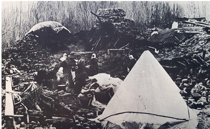
Figura 1.1 Tienda de campaña en las ruinas de una casa después del terremoto en el este de Turquía 1939, M_w = 6.0 ( Davis, 1978 ).
