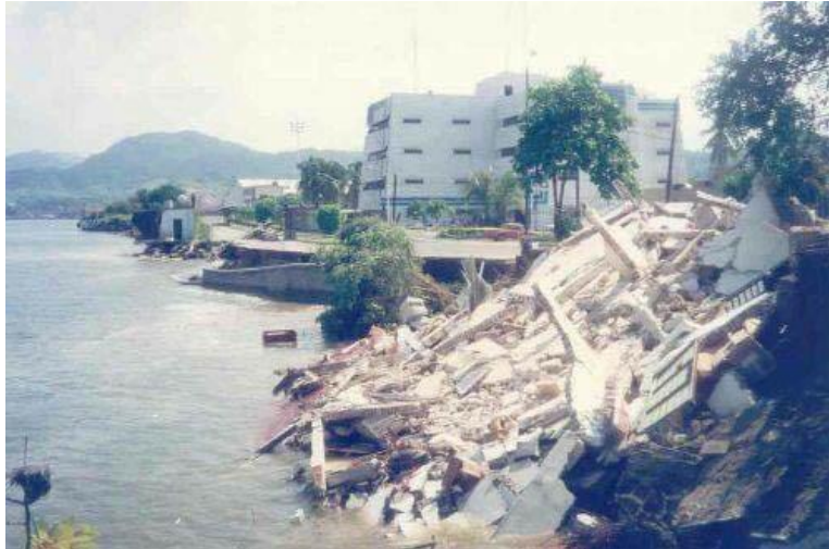
Figura 2.4 Colapso de edificaciones debido al sismo M_w= 8.0 en Manzanillo, Colima de 1995 (AFM, 2017).
