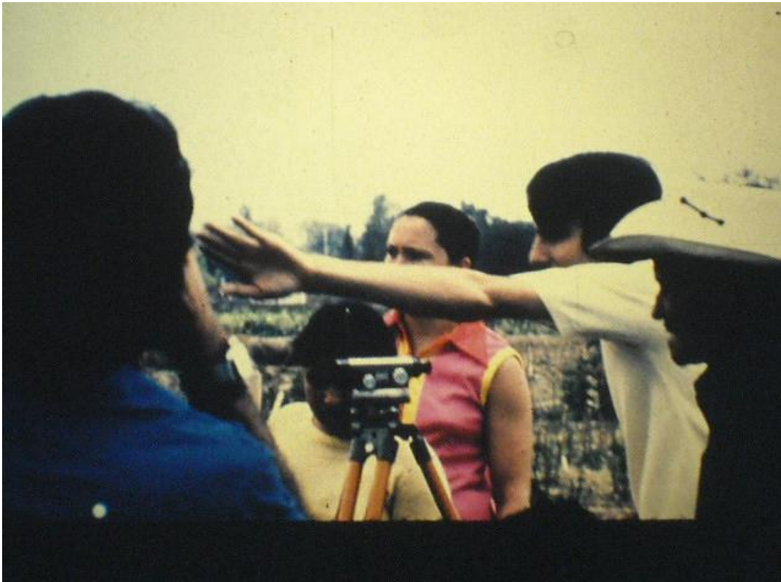
Ilustración 52. El arquitecto Alberto Escobar coordinando los trabajos de construcción en Colli Sítio. Fuente: HMMB - Cervantes, 2010.
