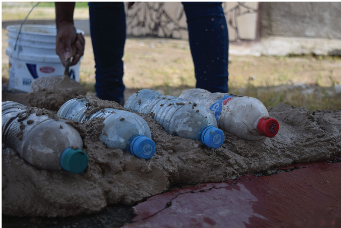
Imagen 28. Proceso de construcción de bancas. Foto Michelle Moreno
