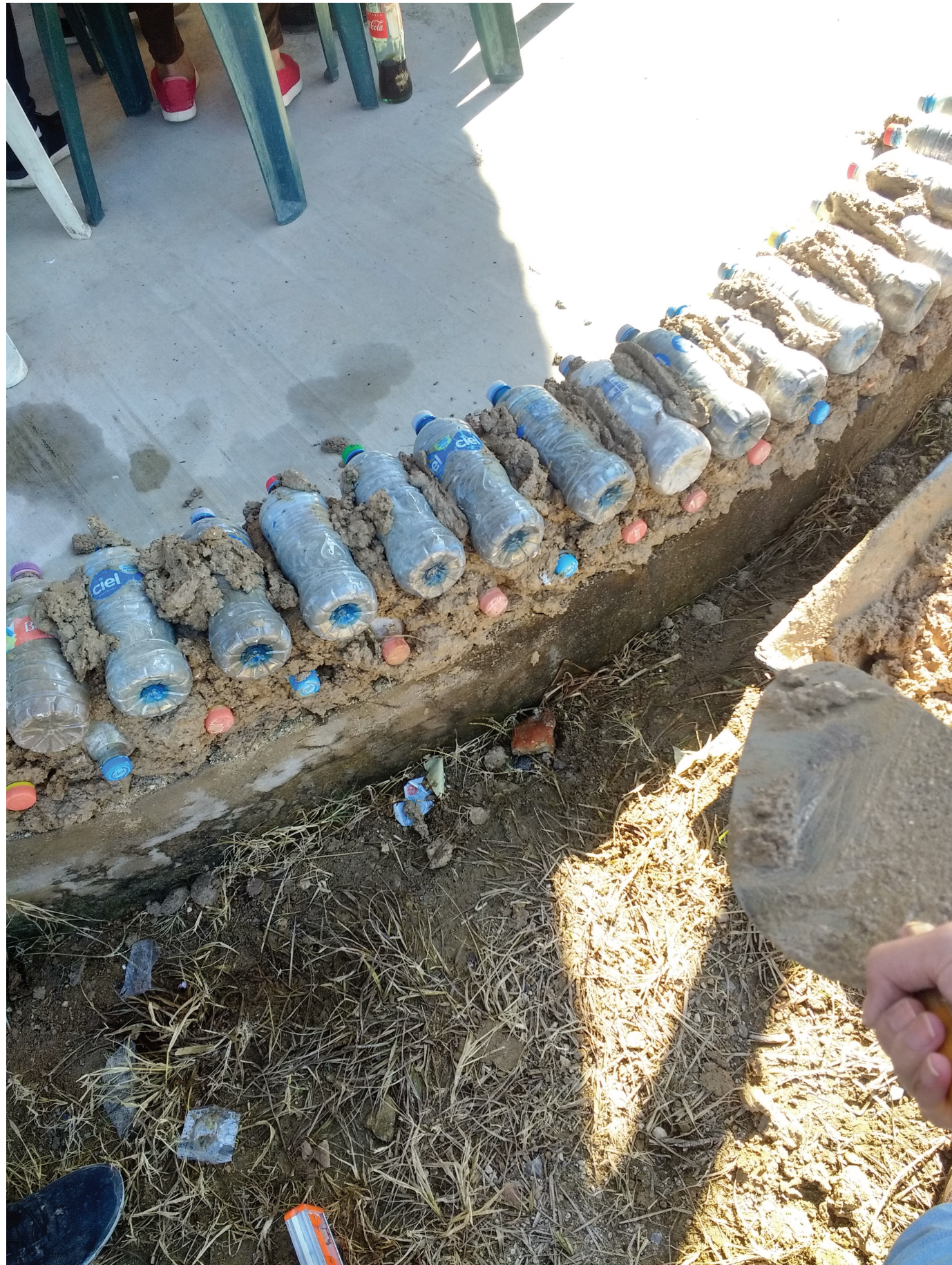
Imagen 30. Proceso constructivo. Foto Karla Cervantes
