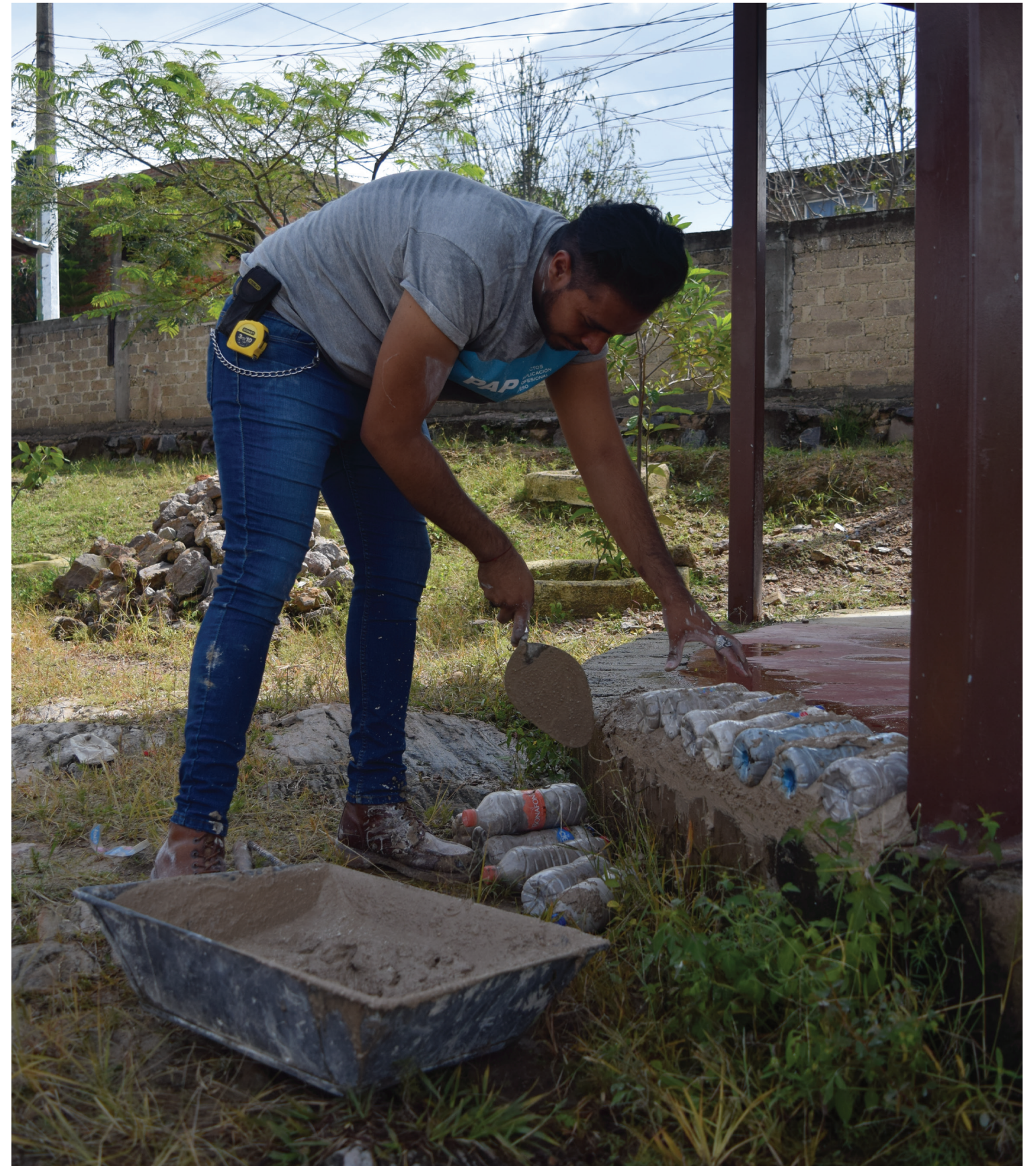
Imagen 29. Proceso constructivo de bancas. Foto Michelle Moreno
