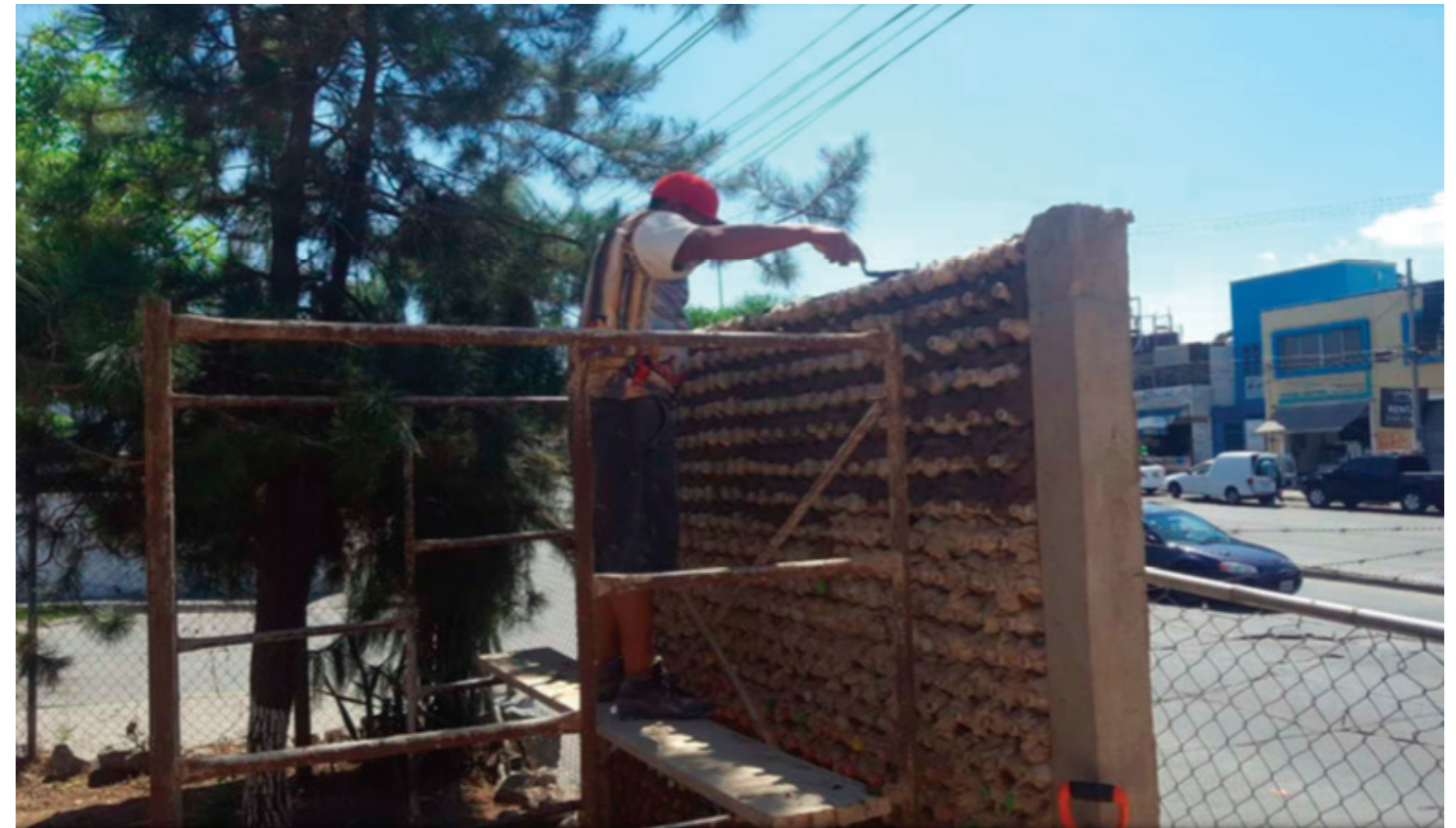
Imagen 85. Construcción con botellas PET
