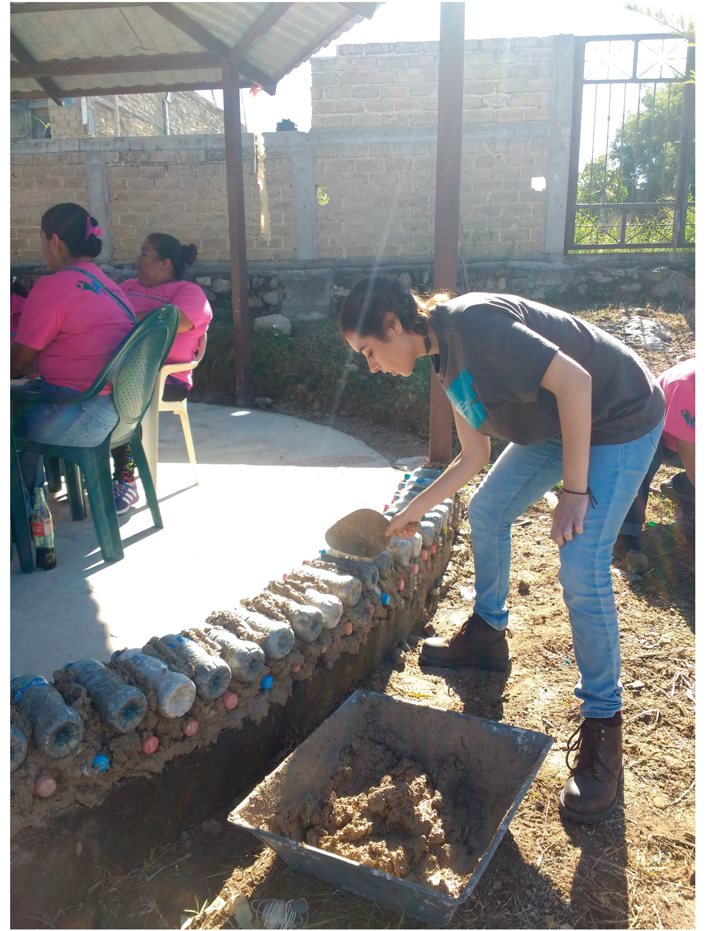
Imagen 31. Proceso constructivo. Foto Michelle Moreno
