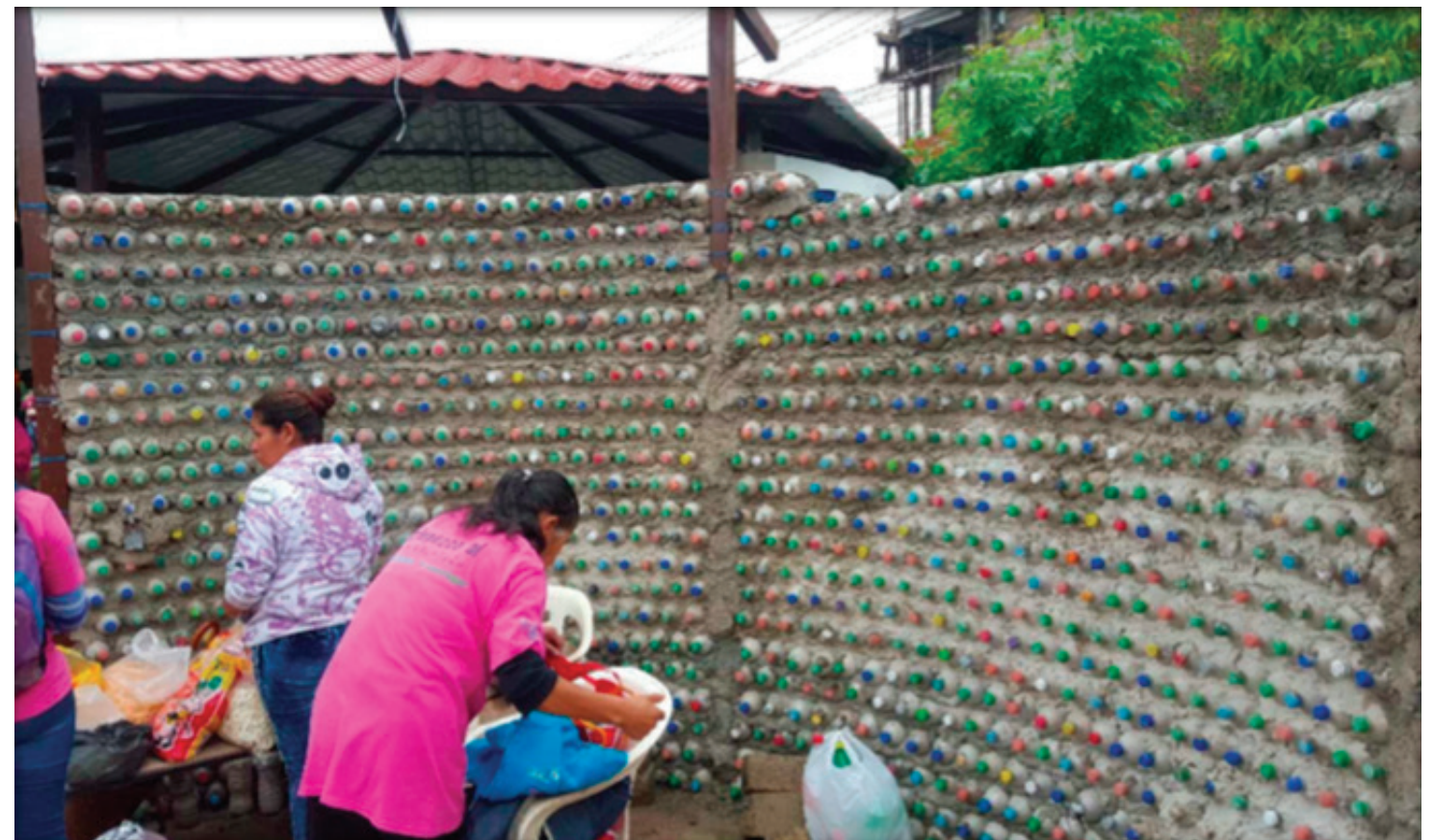
Imagen 86. Construcción con botellas PET
