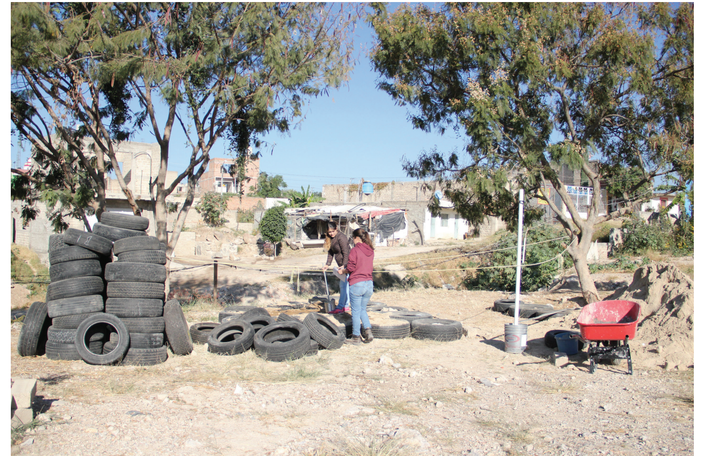
Imagen 52. Colocación de tierra en la base de la pirámide. Foto por Carlos Estrada
