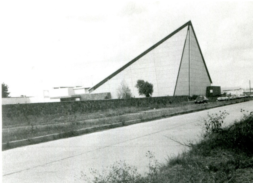
Foto 8. Sinagoga construida a principios de la década de los setenta.
