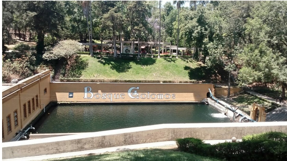
Fotografía 5. Vista de espacio para captación de agua en Bosque Colomos
