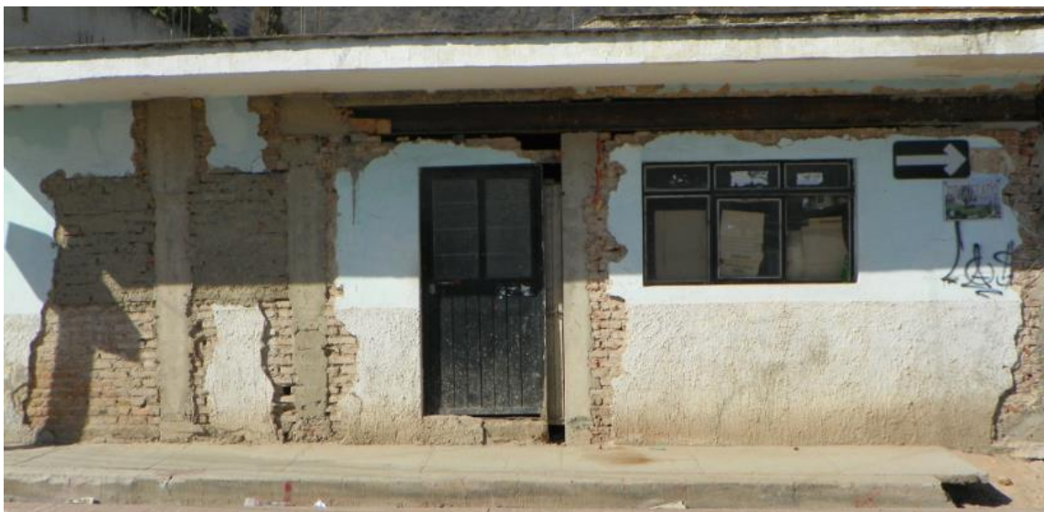
Figura 4.5. Vivienda V4 de la manzana 1 con intervención estructural.
