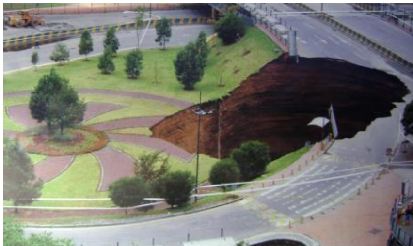
Figura. 2.5. Fase inicial de sinkhole (Toulkeridis et al., 2016).
