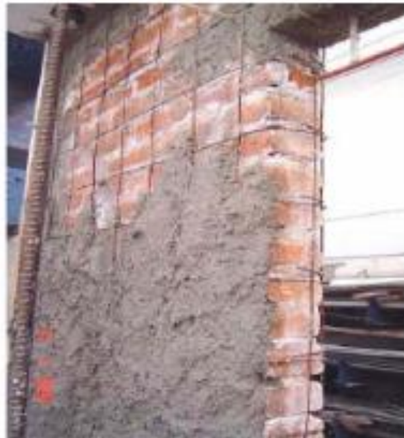
Figura. 2.12. Intervención estructural con malla electrosoldada y mortero (Ruiz, 2007).
