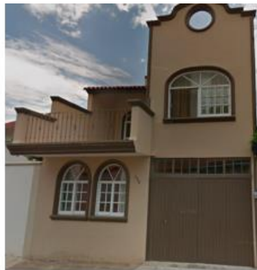
Figura 5.5 Evaluación de vulnerabilidad sísmica vivienda de mampostería no reforzada mal confinada, vivienda V3 en manzana M1.
