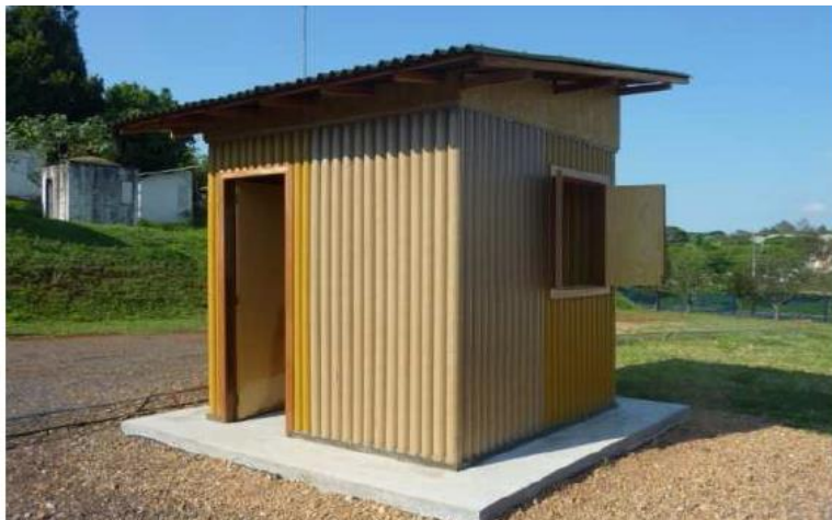
Figura. 2.7. Sistema constructivo con paneles de tubos de cartón (Salado y Sichieri, 2014).
