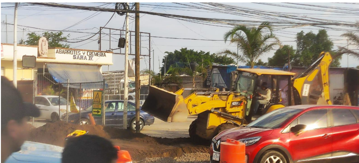
Figura 57. Maquinaria pesada comienza con trabajos a unos metros del área de juego improvisada.
