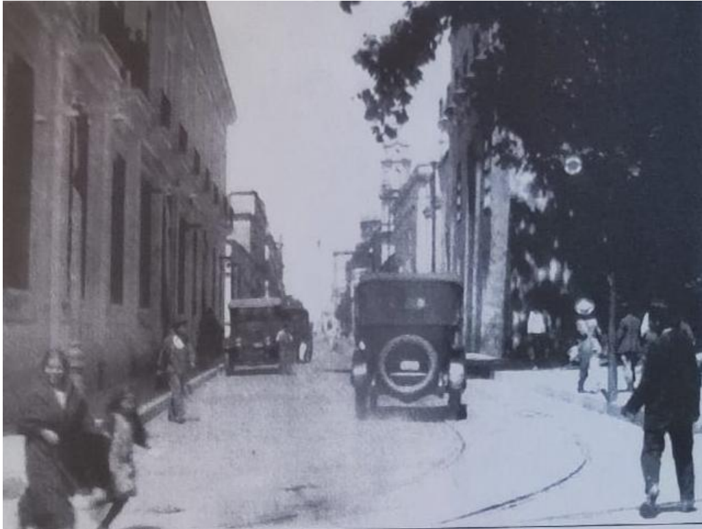
Figura 1. Av. Fray Antonio Alcalde antes de su ampliación en 1920. Hernández. (2001)
