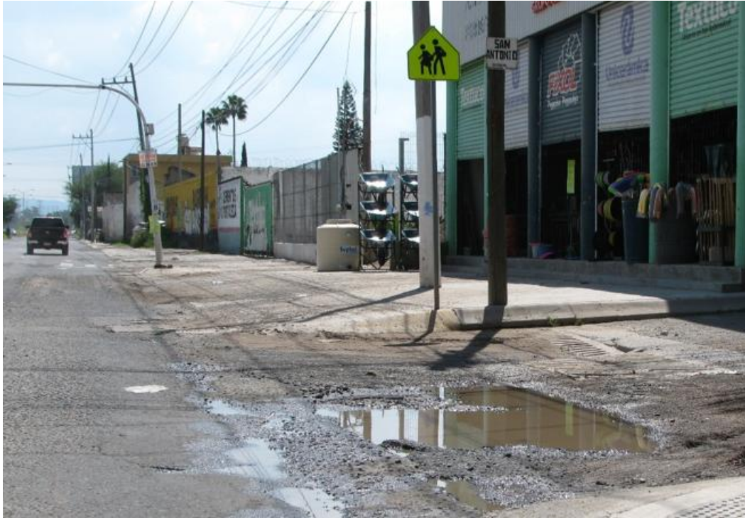
Figura 41. Segmento de av. Prolongación Colón en mal estado. Imagen: Abel Gómez (2025)
