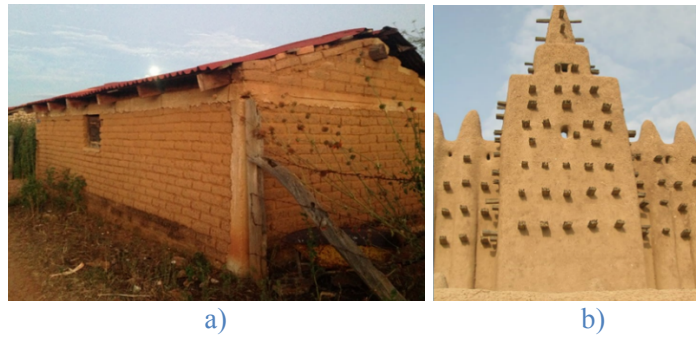
Fig. 2.2: Construcción con tierra; a) vivienda hecha de adobe confinado, Jalisco y b) 1988 Djenné, Malí (UNESCO, 2012).
