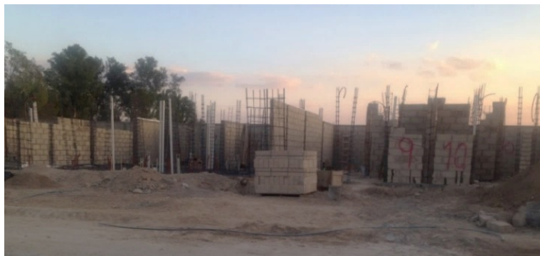
Fig. 1.1: Construcción de viviendas por sistemas de block de concreto en muros.
