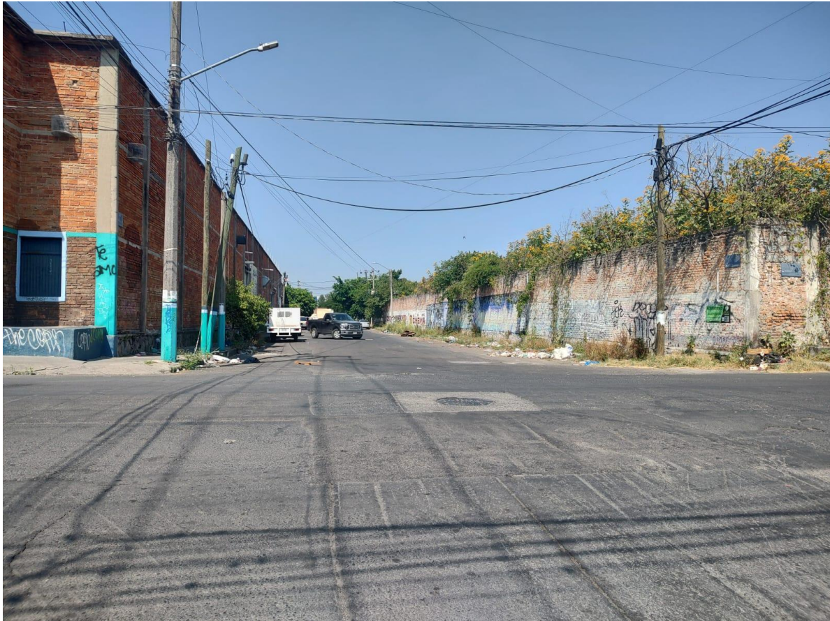
Fig. 27. Fotografía de la calle 6 esquina con la calle 9. El lote del lado derecho no tiene banqueta. Las largas fachadas ciegas generan una percepción de inseguridad. Los postes terminan siendo el elemento más visible, con cables de energía colgando de manera excesiva y desorganizada. El arroyo vehicular presenta grietas y desgaste a causa de los vehículos de carga pesada. Fotografía propia.
