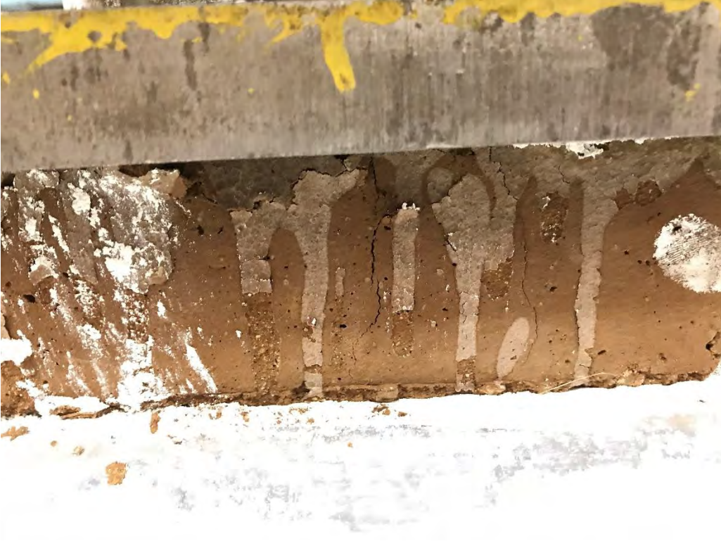
PISO DE TIERRA-1 DESPUÉS DE LA PRUEBA A COMPRESIÓN.
