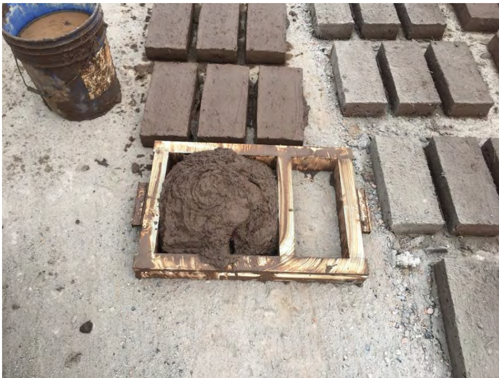
Figura 2.10. Molde adobe elaborado en aluminio, en el Sauz de Cajigal, al norte del municipio de Arandas. Fuente: Elaboración propia, 2019.
