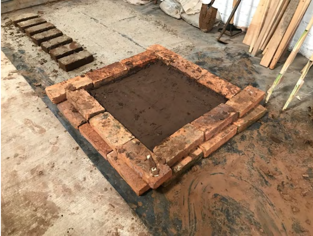
Figura 4.12. Vaciado de la mezcla de tierra sobre el entramado de carrizo. Fuente: Propia, en trabajo de campo 2021.
