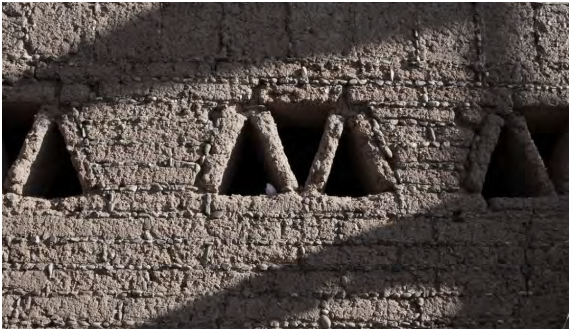
Figura 2.1. Muro de adobe con celosía en San Sebastián Teponahuatlán, Jalisco. Fuente: Propia, en trabajo de campo 2019.
