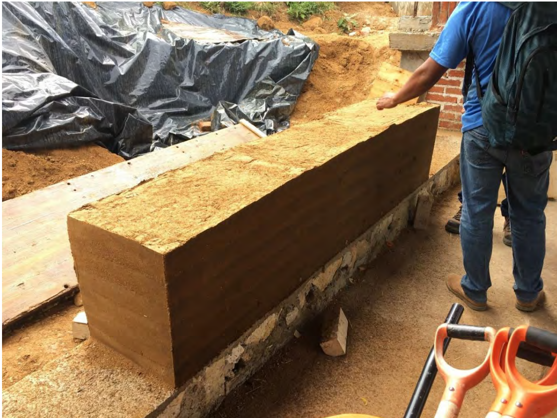
Figura 2.13. Murete de tapial en el centro IBOMEX, Oaxaca, México. Fuente: Elaboración propia, 2019.
