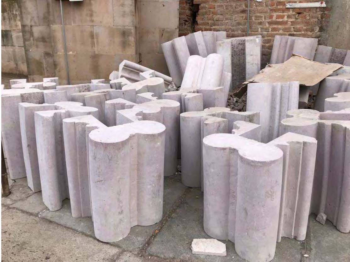
Figura 2.17. Molduras de cantera para la construcción de la girola del templo de San José obrero, en Arandas, provenientes de Degollado, Jalisco. Fuente: Elaboración propia, 2020.
